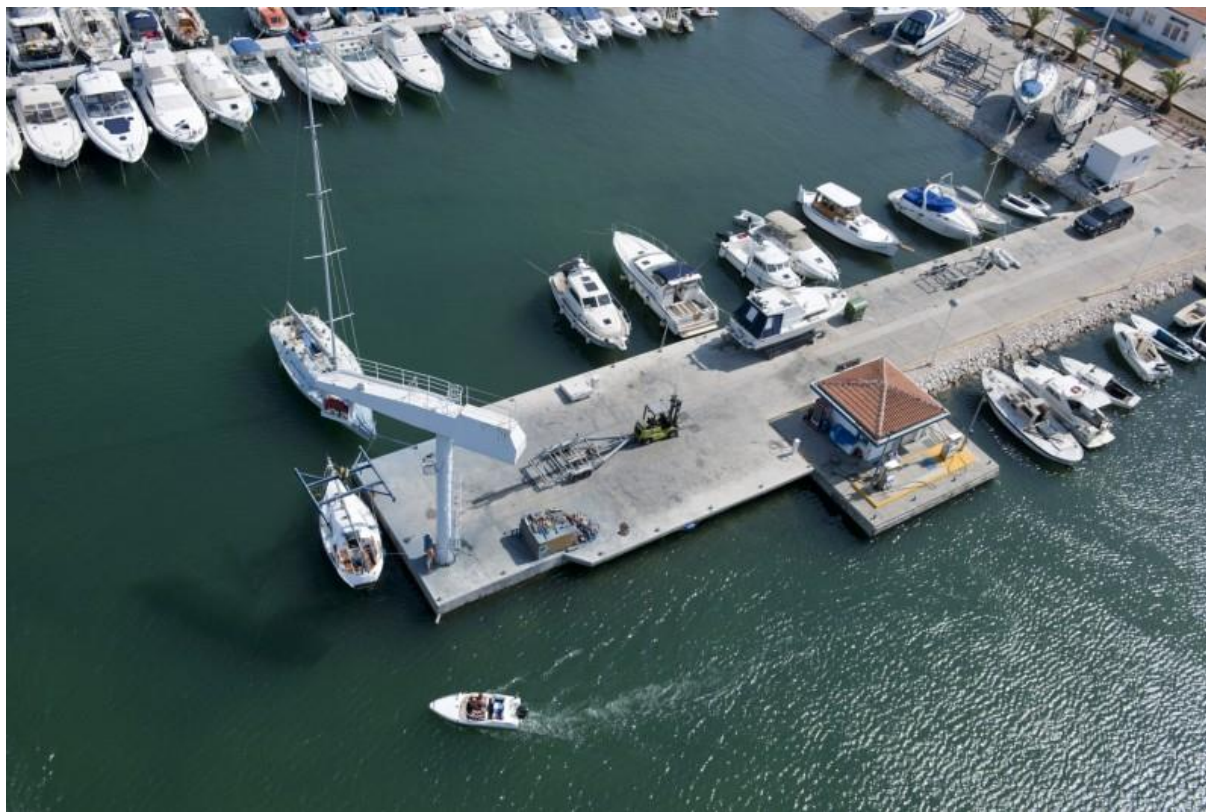
Slika 4. Zatečeno stanje - 10 tonska stupna dizalica na servisnom gatu
