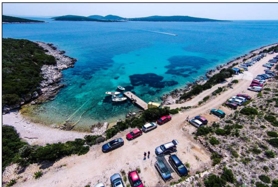
Fotografija 1: Postojeće stanje u uvali Mrtvaška (Izvor: Idejni projekt dogradnja luke za javni promet Mrtvaška na otoku Lošinju, RIJEKAPROJEKT d.o.o., Rijeka, ožujak 2019.)
