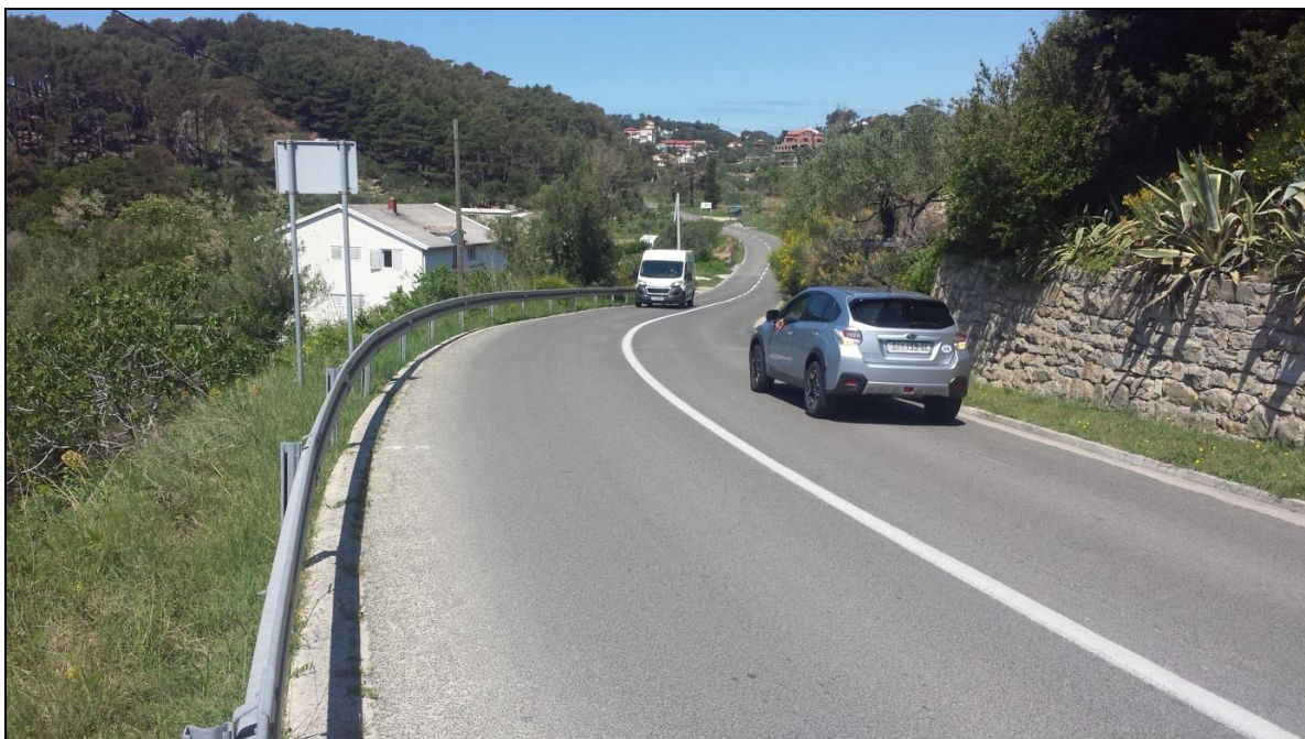
Slika 3.1.12-2. Pogled po trasi na početnom dijelu zahvata (stac.0+800km)
