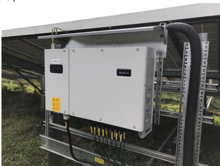
Slika 1.1.-5.: Primjer montaže izmjenjivača niza
