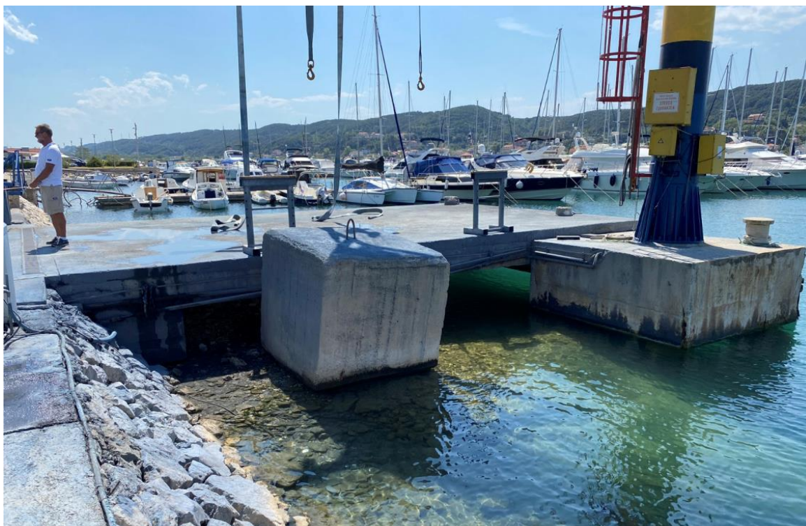
Slika 1.1-1.: Postojeća stupna dizalica u ACI marini Supetarska Draga (Izvor: Idejno rješenje; modificirao Zeleni servis d.o.o.)
