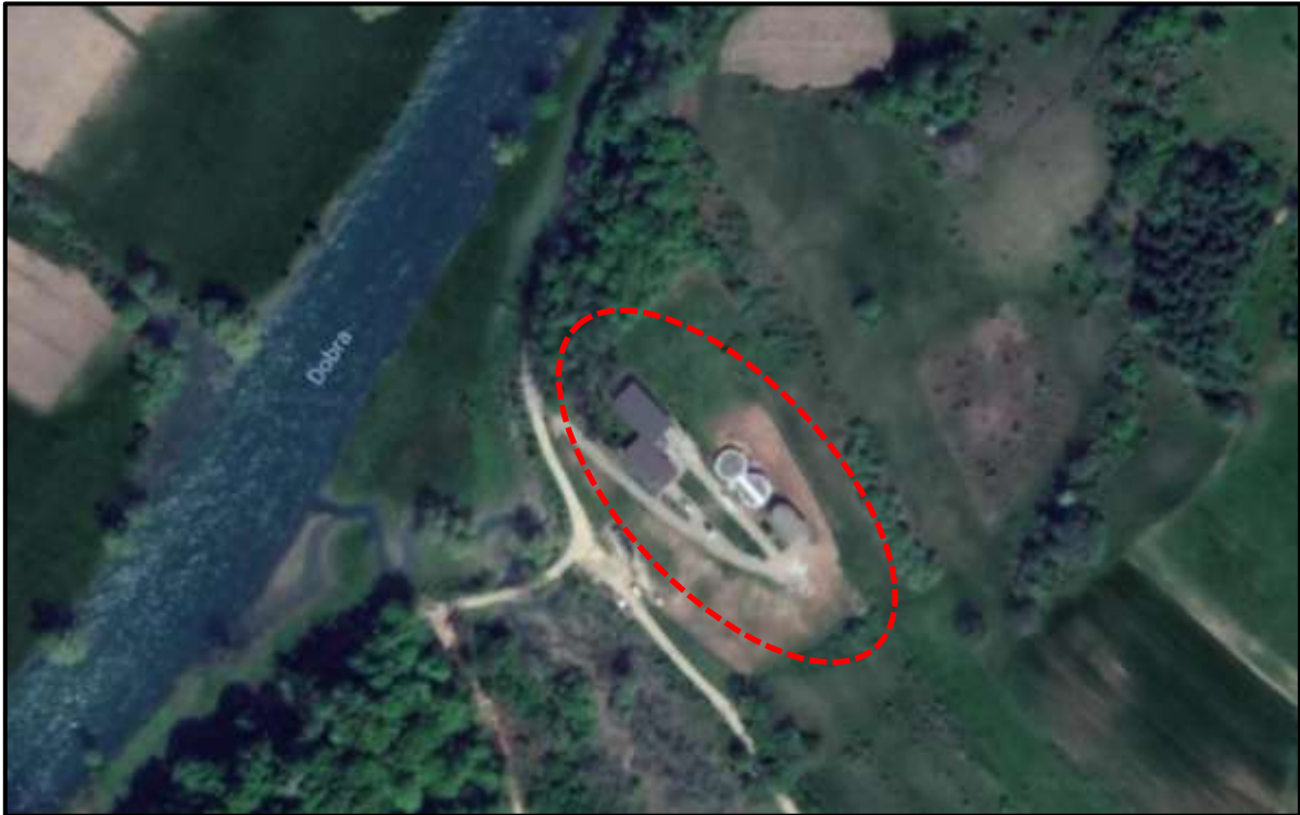
Slika 2.1-3. Postrojenje za obradu vode Novigrad na Dobri (izvor: Google Earth, 2019.)
