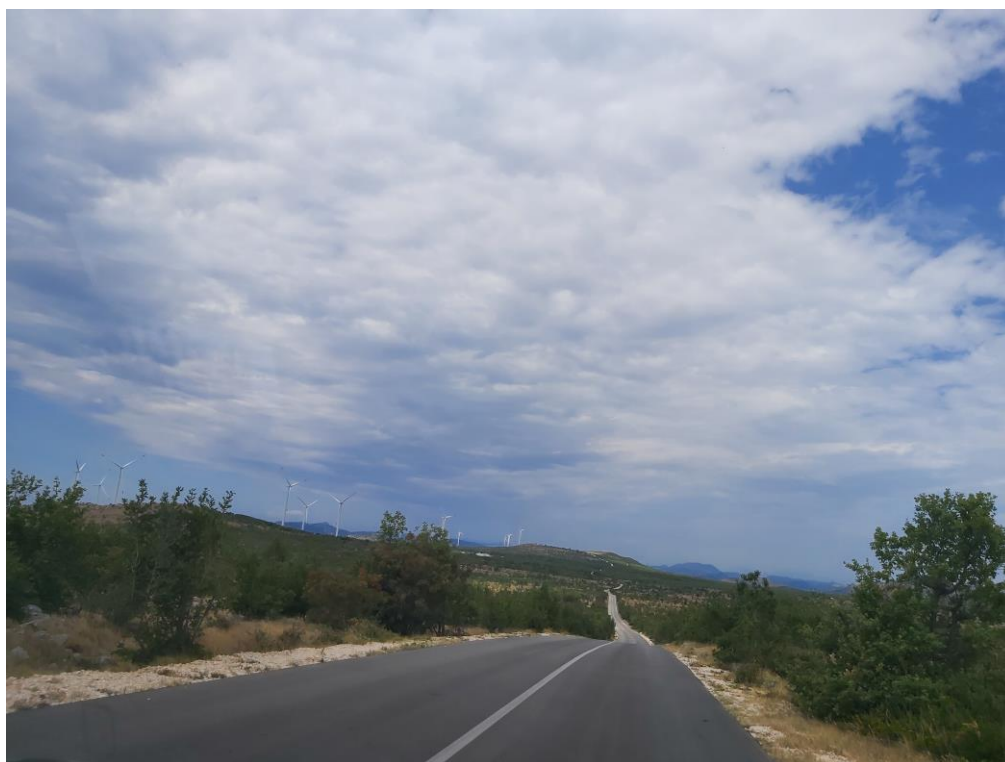
Slika 15. Fotodokumentacija s lokacije zahvata – županijska cesta ŽC6228 (Gr. BiH-Rudine-Slano-A.G. Grada Dubrovnika), pogled na vjetroelektranu Rudine
