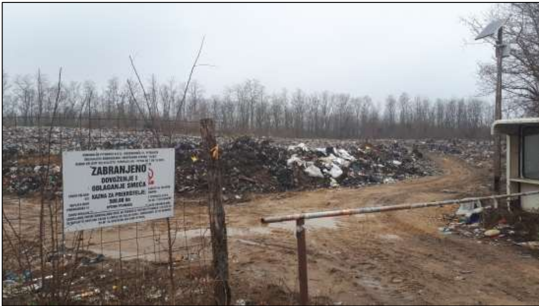
Slika 1 Postojeće stanje na odlagalištu Klisa (studeni 2018.)
