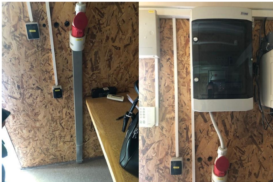
Sl. 2.1-3: Kutija za isključenje električne energije na mjernoj postaji Sisak - 2 Galdovo
