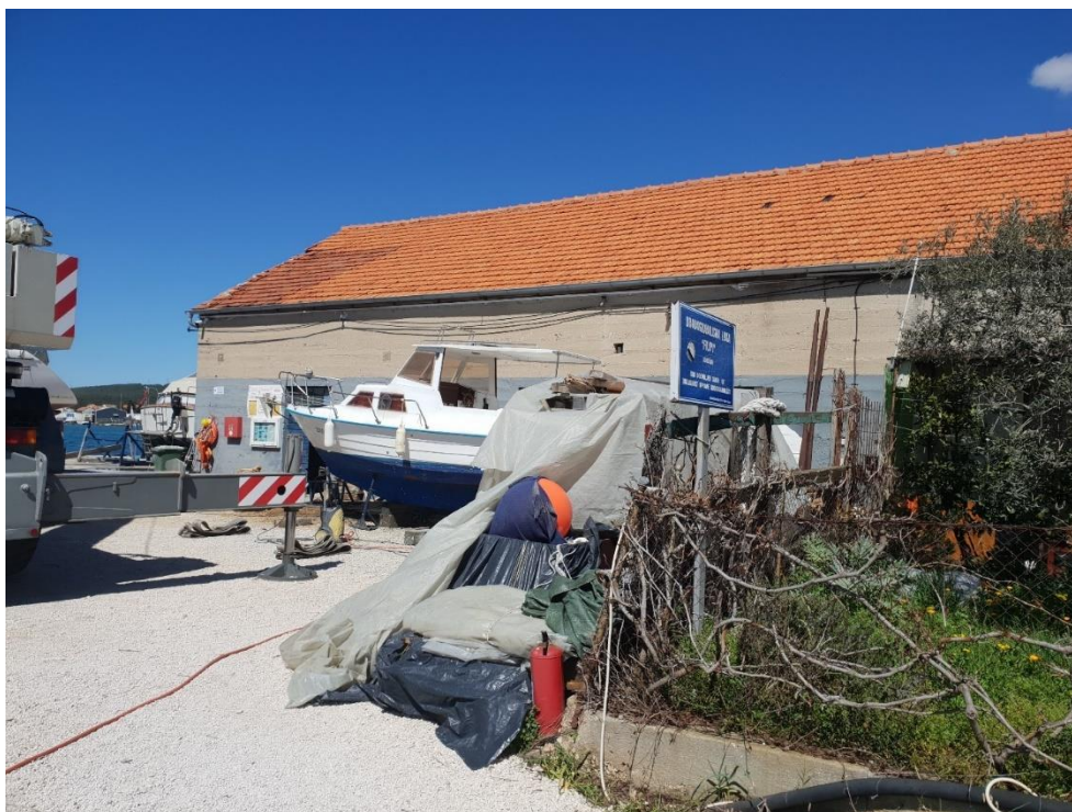
Slika 1.1-2 Građevina A (jugozapadna fasada)
