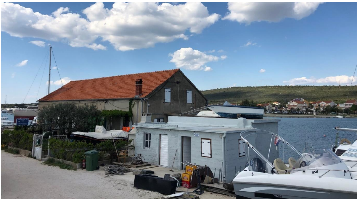
Slika 1.1-3 Građevina B (jugozapadna fasada)
