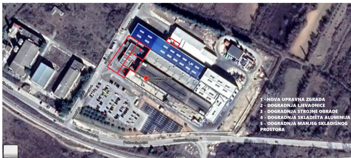
Slika 2: Satelitska snimka tvornice LTH Metalni lijev sa označenim dijelovima tvornice obuhvaćenih rekonstrukcijom
