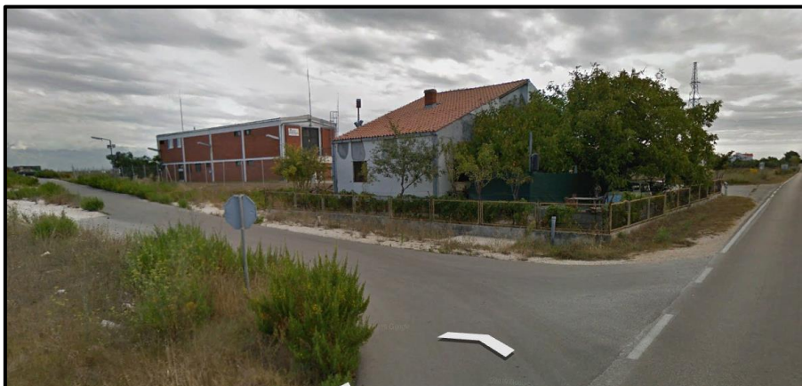
Slika 2.1-7. Postojeći sadržaji na lokaciji zahvata snimljeni sa županijske ceste Ž6011: trafostanica Nin s pomoćnim objektom (izvor: Google Earth, 2020.)
