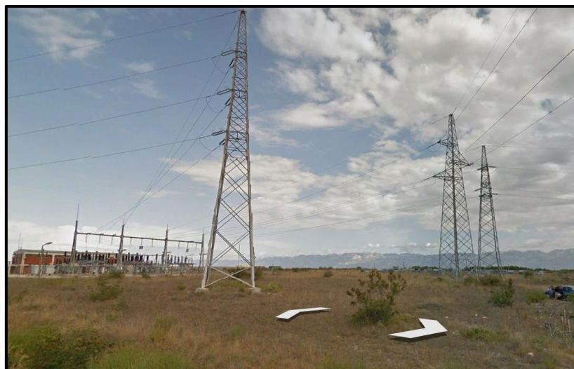
Slika 2.1-5. Postojeći sadržaji na lokaciji zahvata snimljeni sa županijske ceste Ž6011: stupovi vodova VN dalekovoda 110 kV (izvor: Google Earth, 2020.)
