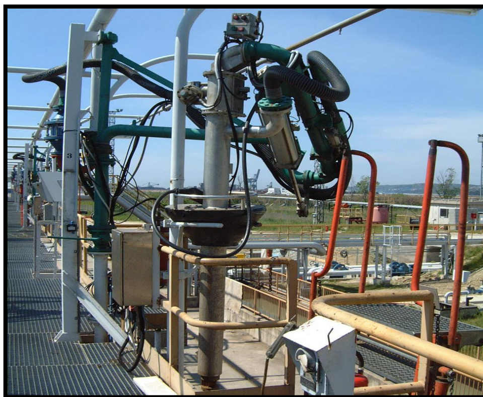
Slika 11. Primjer ruke za gornje punjenje vagonskih cisterni sa povratom para
