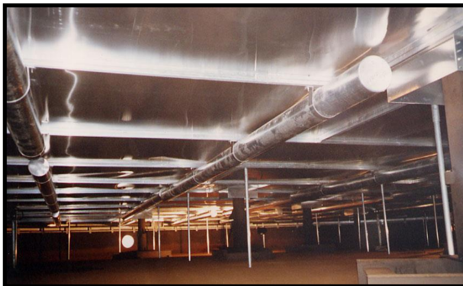
Slika 8. Primjer ugrađenog unutarnjeg plutajućeg pokrova u spremniku
