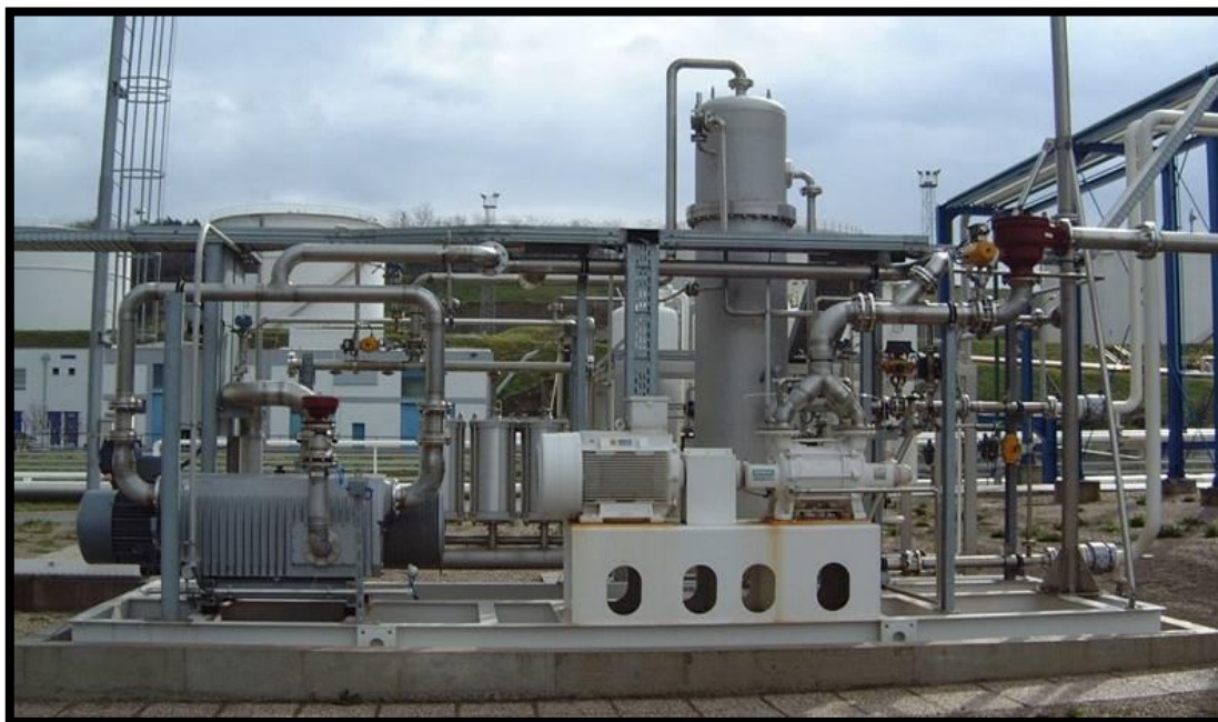
Slika 15. Prikaz jedinica za obradu para ugljikovodika (VRU) na distribucijskim terminalima
