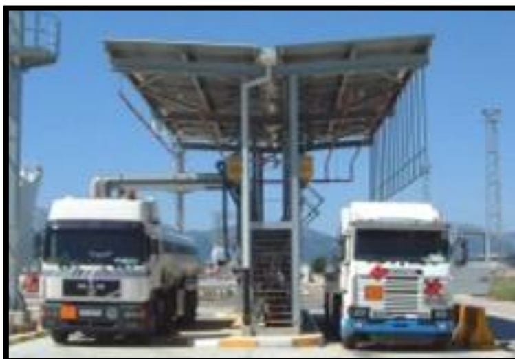
Slika 13. Primjer kombiniranog otoka za punjenje kamionskih cisterni
