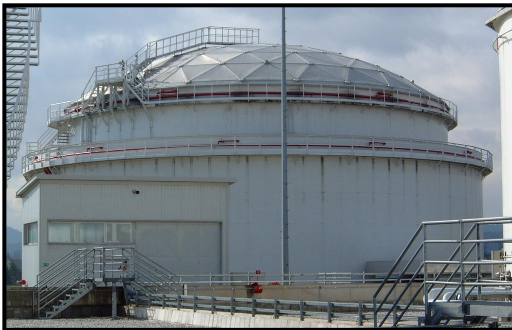
Slika 6. Primjer spremnika s aluminijskom reflektirajućom kupolom i čeličnom tankvanom
