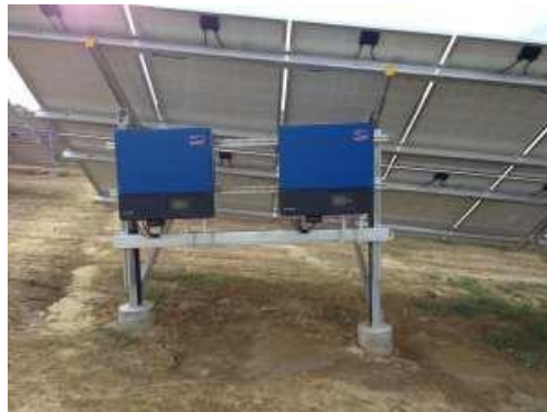
Slika 3: Način montaže invertera na podkonstrukciju
