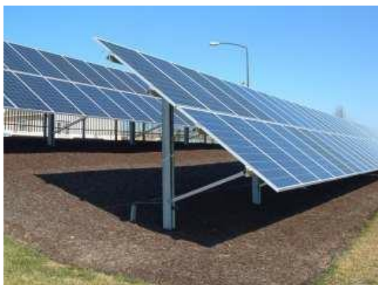
Slika 2: Detalj montaže na zemljanoj površini
