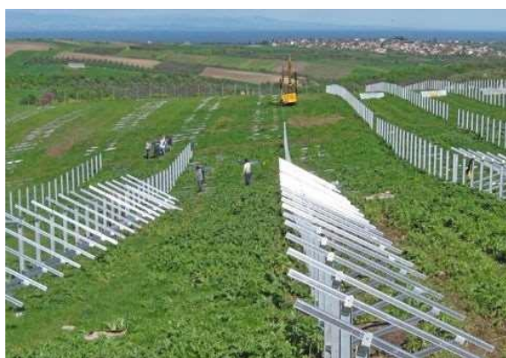
Slika 2: Detalj montaže na zemljanoj površini
