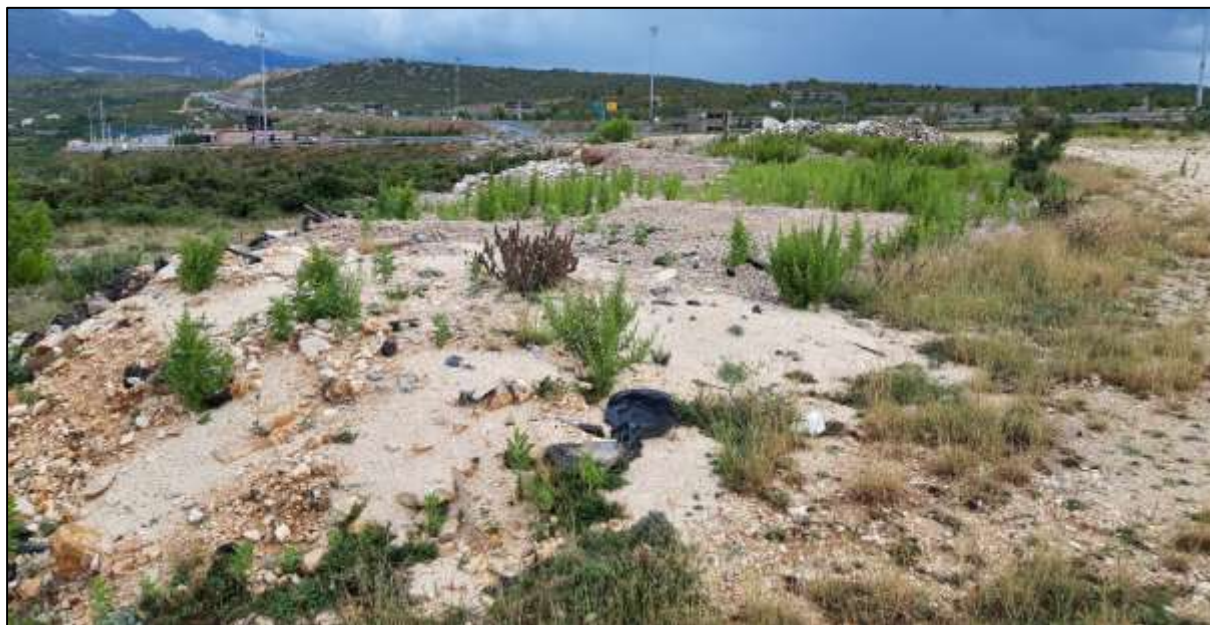
Slika 2.2.2.2-3 odloženi iskopni materijal sa sjeverne strane lokacije, predviđen za ravnanje i prepuštanje prirodnoj sukcesiji.
