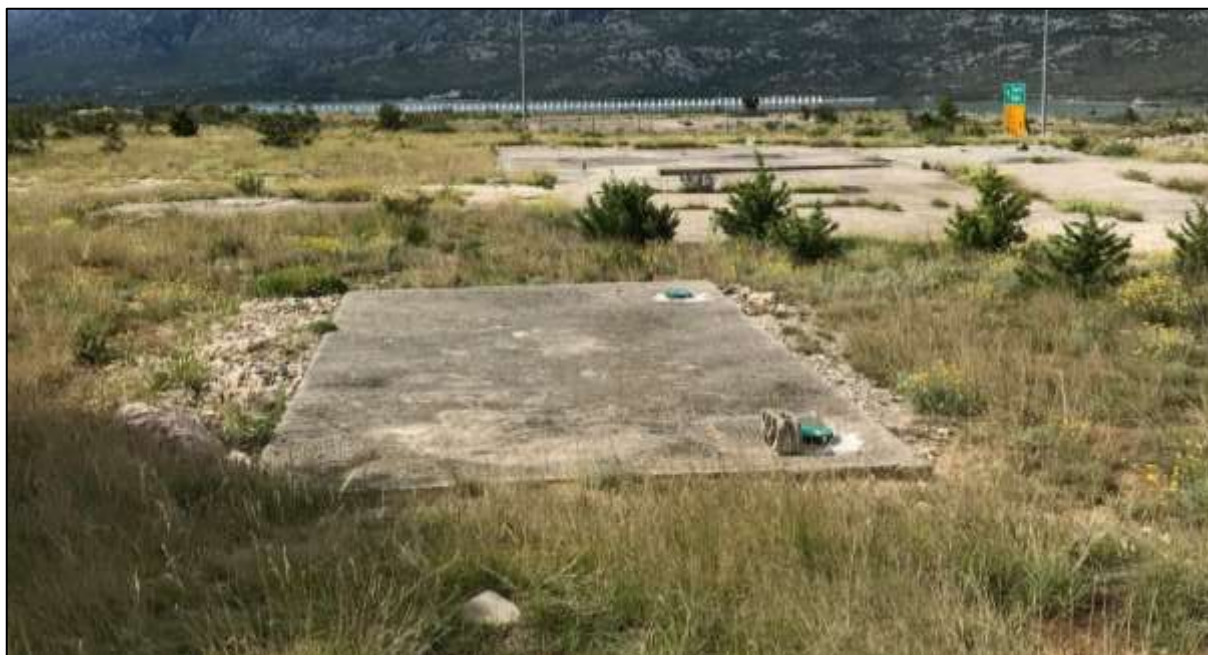
Slika 2.2.2.1-6. spremnik ispred objekta 2, pretpostavlja se kako se radi o spremniku sanitarne vode. Sadržaj spremnika terenskim obilaskom nije potvrđen jer su poklopci bili zaključani.
