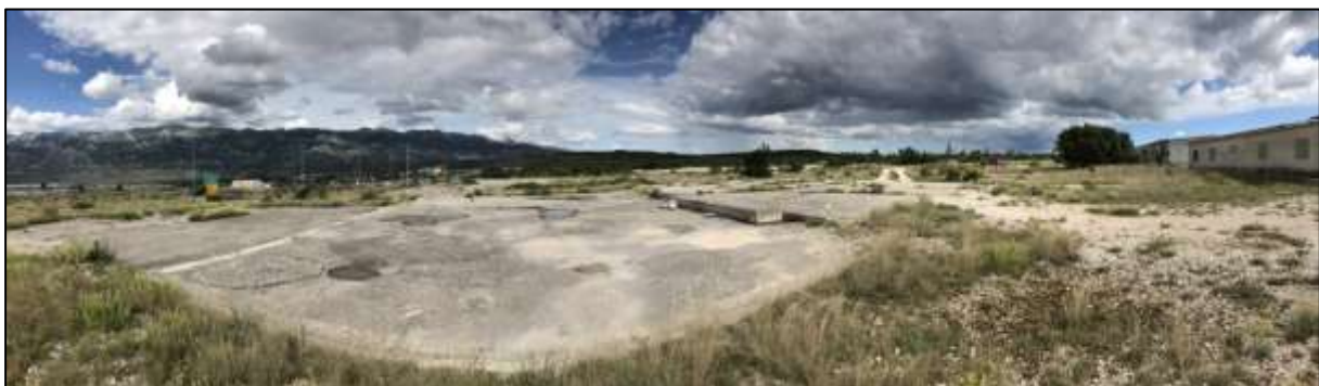
Slika 2.1.-9. LOKACIJA 6. sjeveroistočno od objekata 1 i 2 vidljivi su ostaci ostalih objekata u obliku betonskih platoa/temelja.
