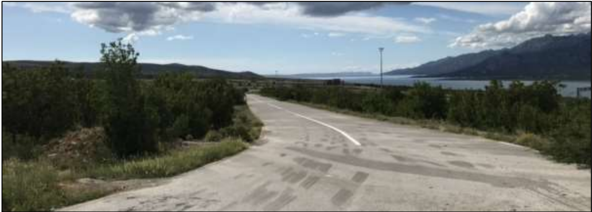
Slika 2.2.2.1-2. pristupna asfaltirano-betonska prometnica.
