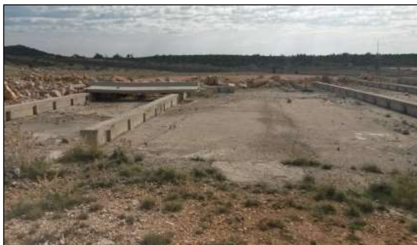
Armirano-betonski plato sa sjeverne strane lokacije od A1
