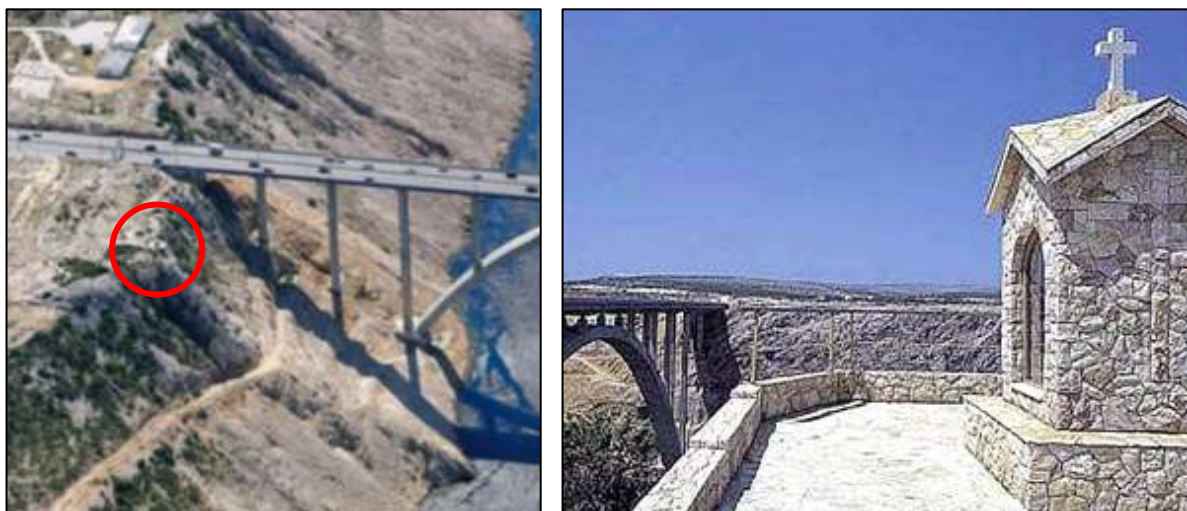
Slika 2.1.-20. LOKACIJA 17. na krajnjem zapadnom dijelu unutar granice obuhvata, nalazi se kapelica koja se planira zadržati u trenutnom stanju te se uz nju neće odvijati radovi.
