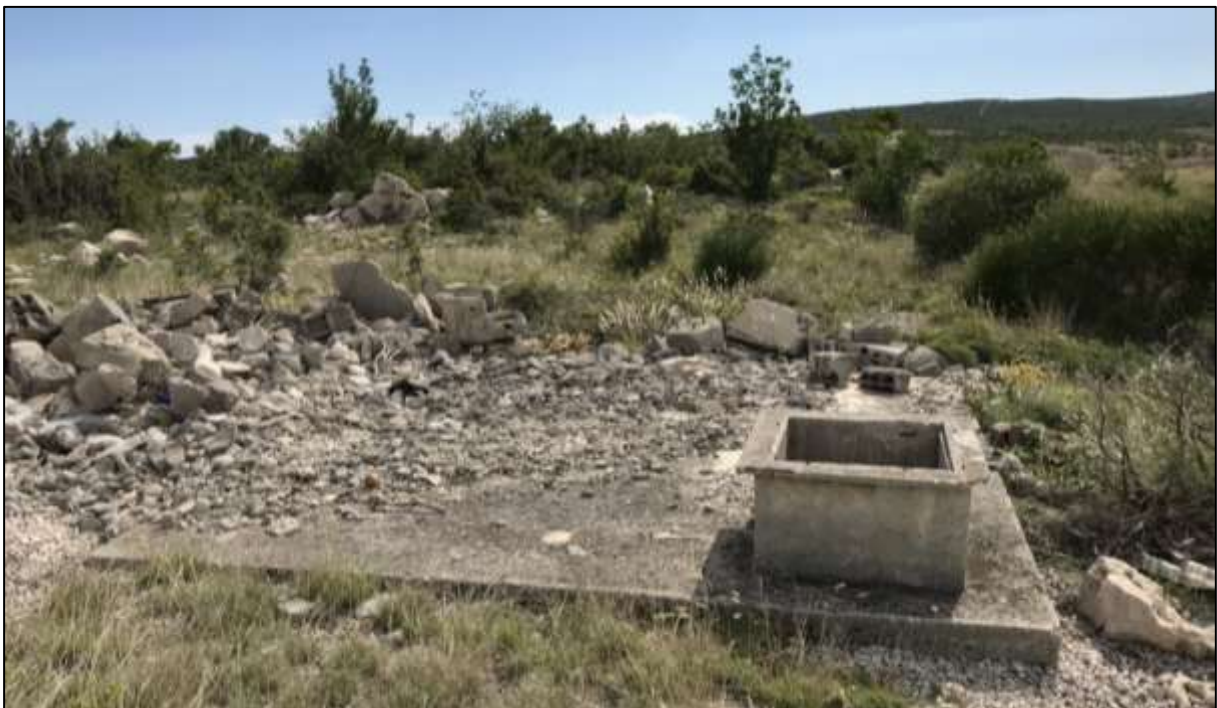
Slika 2.2.2.1-5. sabirna jama uz objekt 1, pretpostavlja se kako se radi o septičkoj sabirnoj jami. U jami je vidljiv tekući sadržaj.
