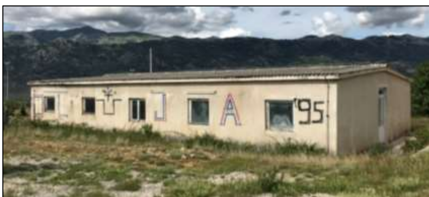
Objekt 2 – južna strana oko 240 m 2 k.č.br. 758/633
