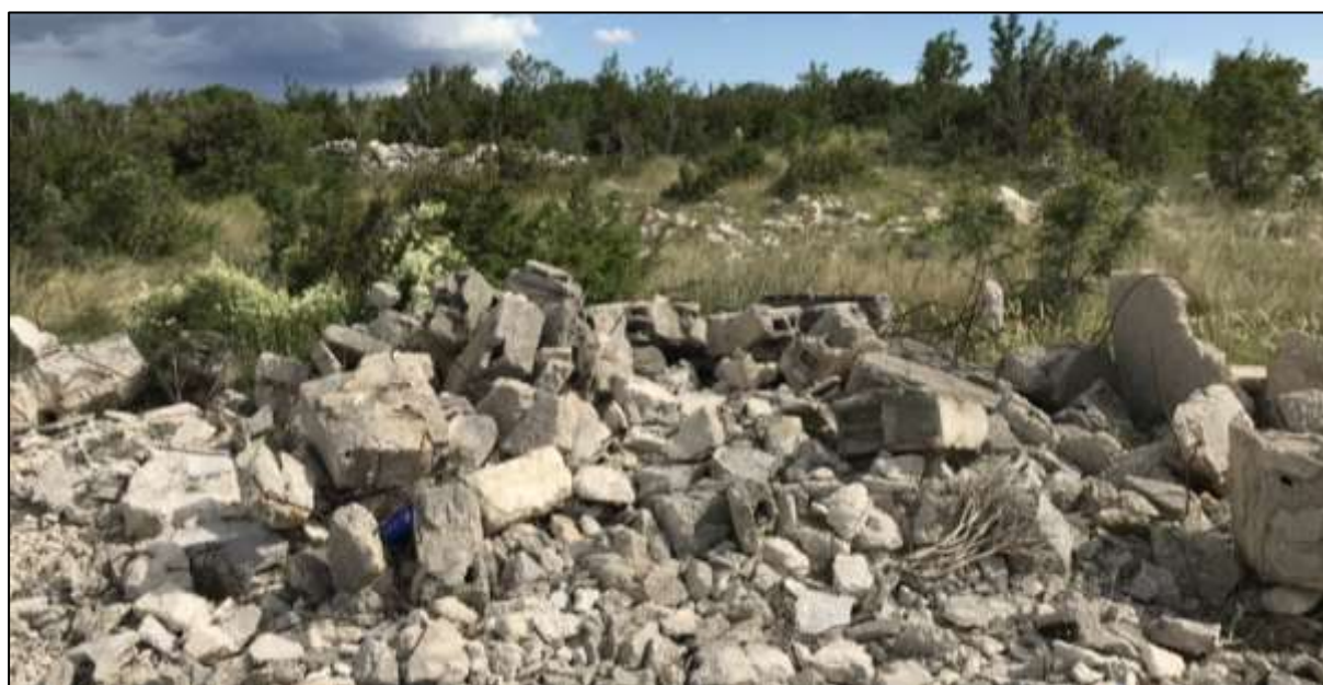
Slika 2.2.2.2-1. odbačeni građevinski otpad, s južne strane lokacije.
