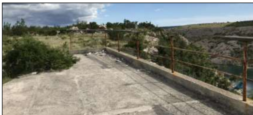
Armirano-betonska terasa/plato iza objekata 1 i 2
