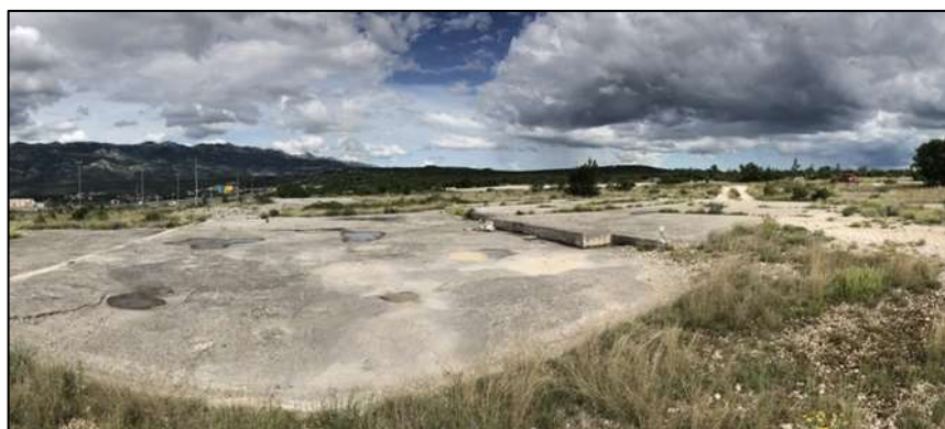
Armirano-betonski plato ispred objekata 1 i 2
