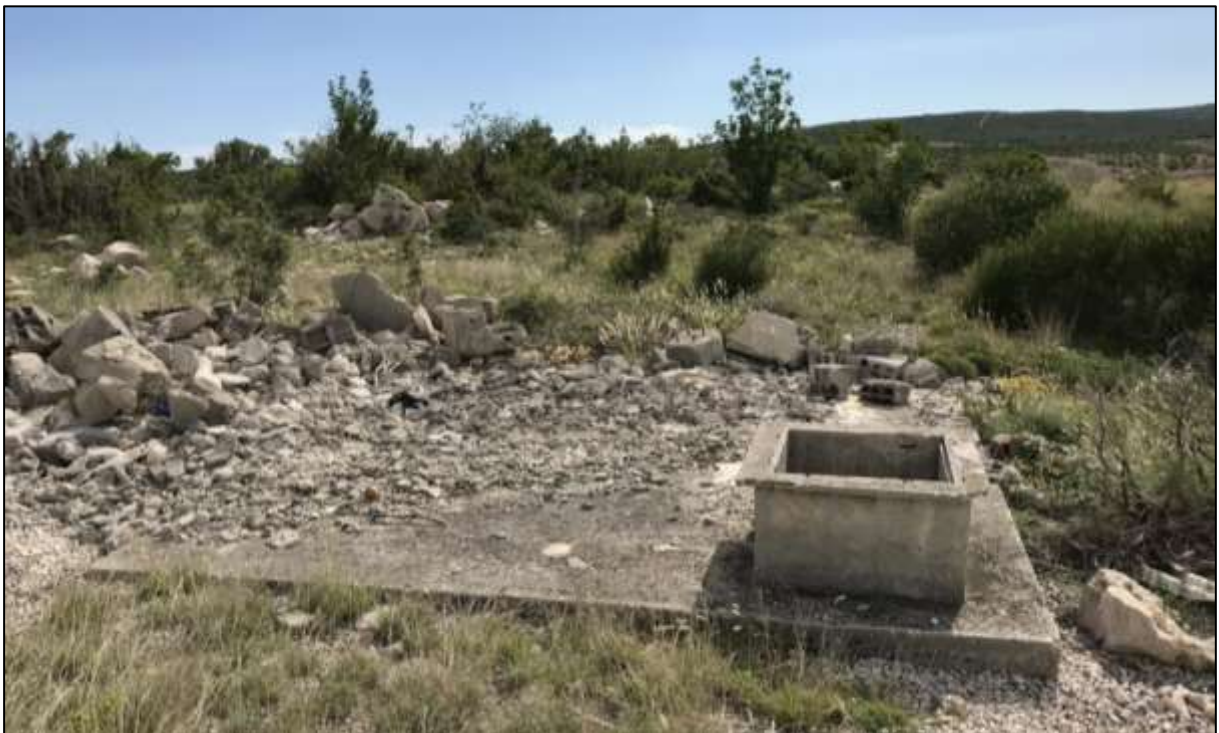
Slika 2.1.-13. LOKACIJA 10. uz objekt 1, s njegove jugoistočne strane nalazi se sabirna jama ili cisterna, nepoznate funkcije tijekom korištenja te trenutno s vidljivim tekućim sadržajem.
