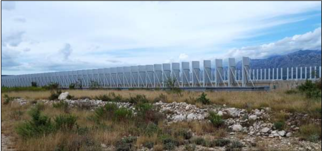
Slika 2.2.2.1-4. pokusno polje burobrana predviđeno za uklanjanje.
