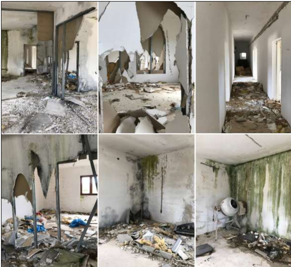
Slika 2.2.2.1-1. prikaz interijera objekata predviđenih za uklanjanje (objekt 1).
