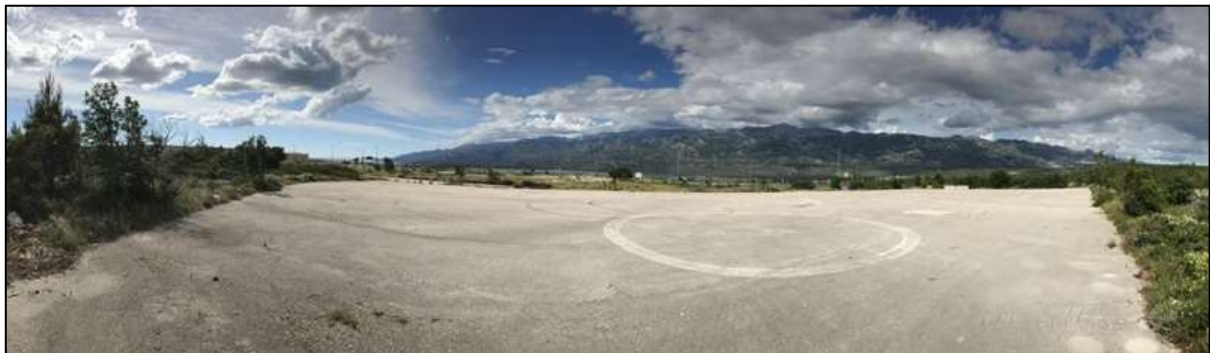
Slika 2.1.-8. LOKACIJA 5. jugoistočno od objekta 1 nalazi se asfaltirano-betonska površina koja je služila kao heliodrom prilikom gradnje mosta.
