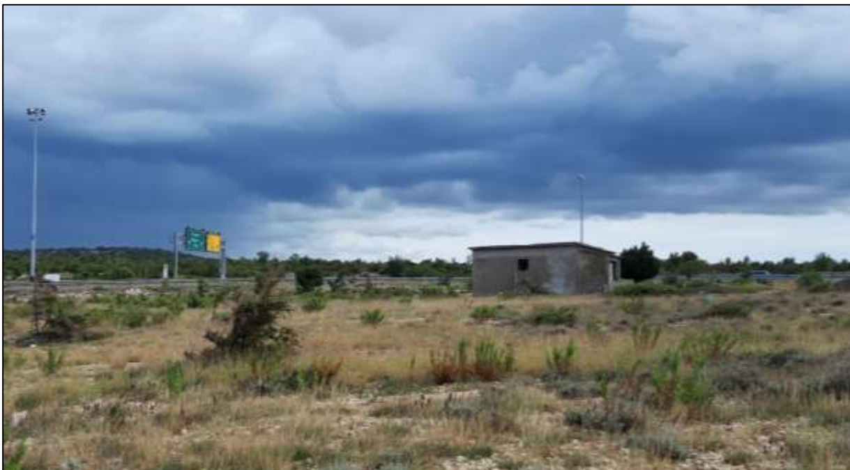
Slika 2.1.-17. LOKACIJA 14. objekt 3 predviđen za uklanjanje, pogled na sjevernu fasadu, u pozadini vidljiva A1.
