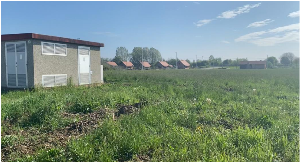
Slika 1.7 Lokacija zahvata i najbliža trafostanica za prihvatanje električne energije
