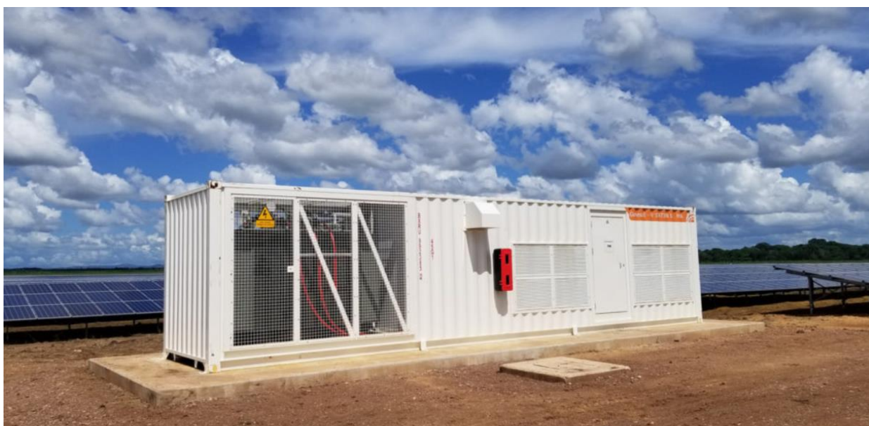
Slika 1./9. Primjer izmjenjivača, Gamesa Electric PV Station 5000; Izvor: www.gamesaelectric.com
