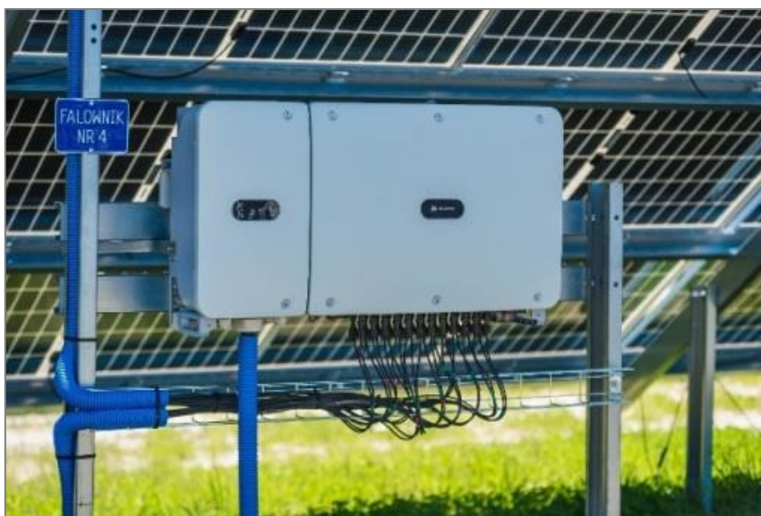
Slika 7. Način montaže izmjenjivača na potkonstrukciju
