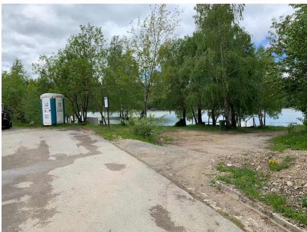
Slika 8 Završetak ceste uz jezero Lepenica Foto: Interkonzalting d.o.o., snimljeno 01.06.2020.
