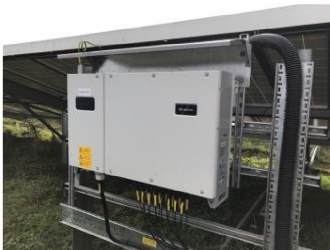
Slika 8. Primjer montaže izmjenjivača niza
