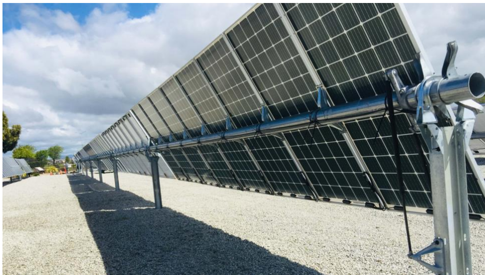
Slika 2.2-4 Načelni prikaz FN modula na zakretnim konstrukcijama po jednoj osi (Izvor: Idejno rješenje „Sunčana elektrana Drniš 2“, TOSKA d.o.o., svibanj 2021.)
