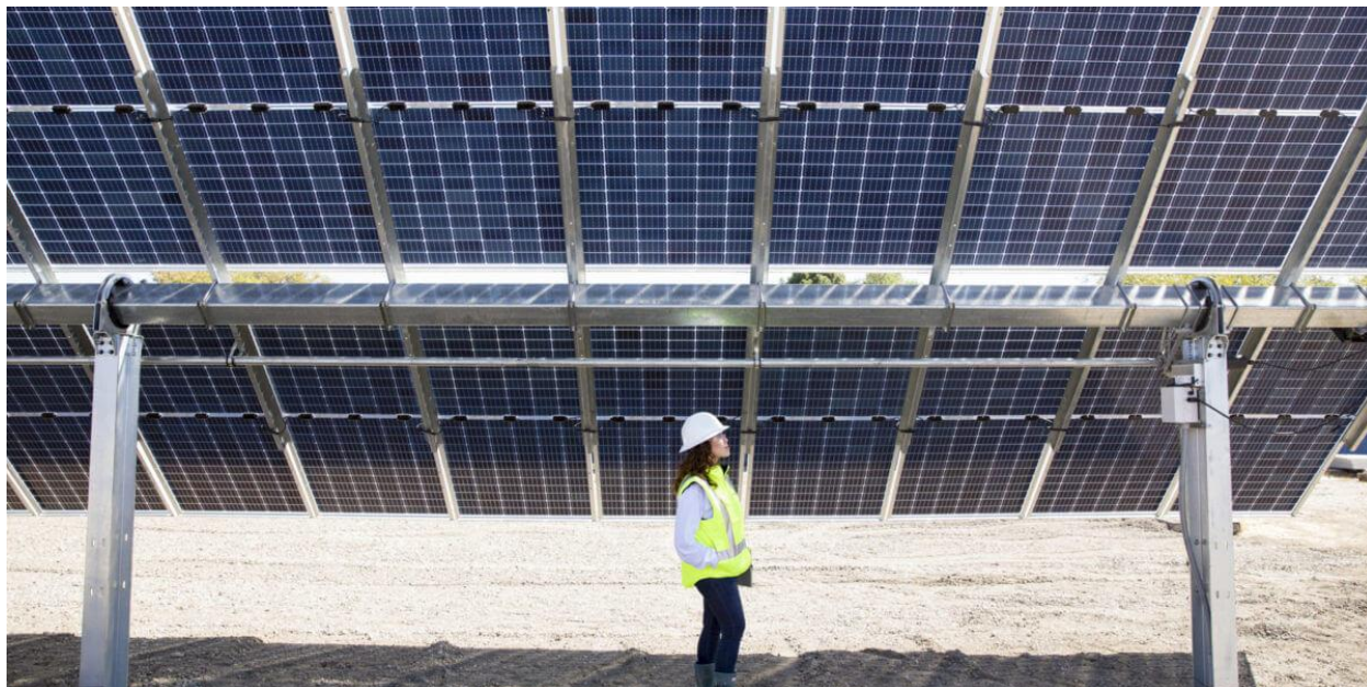
Slika 2.2-5 Sustav za praćenje Sunca model Solarni tracker NX Gemini™ 2P
