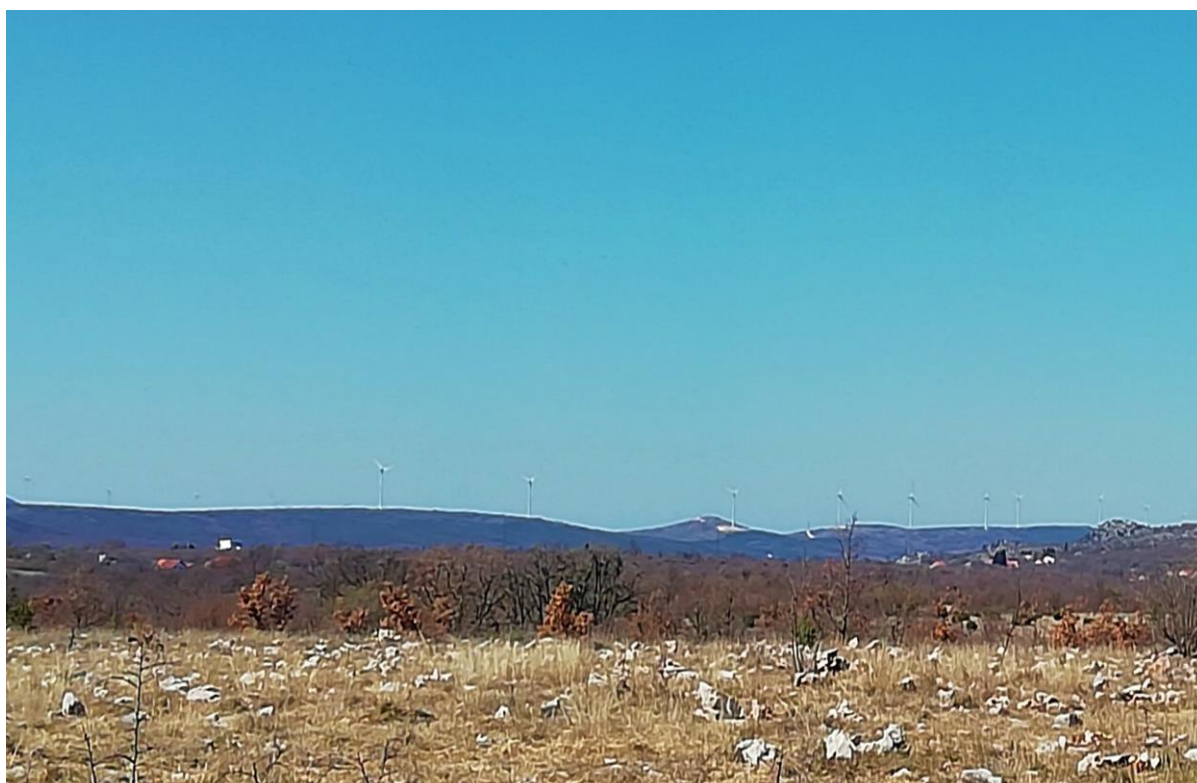
Slika 40. Izgrađena vjetroelektrana VELIKA GLAVA, BUBRIG i CRNI VRH
