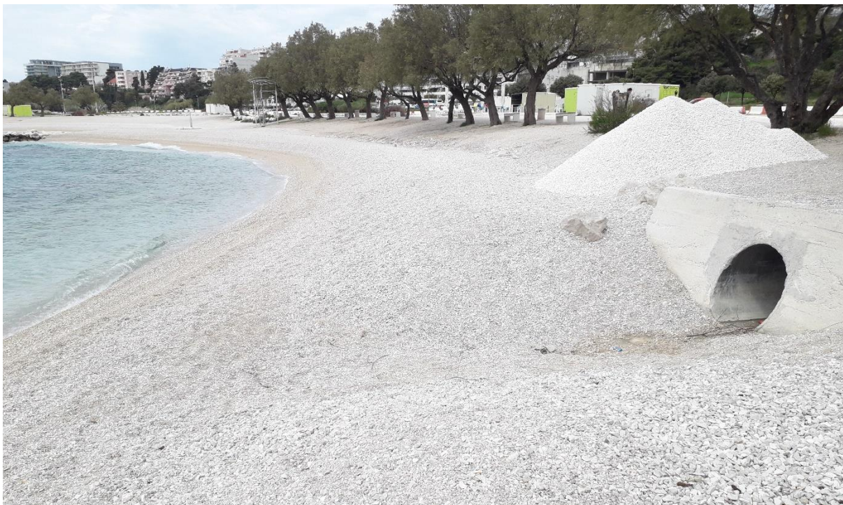
Slika 1.1-2 Postojeći izljev potoka Žnjan 1 na plaži
