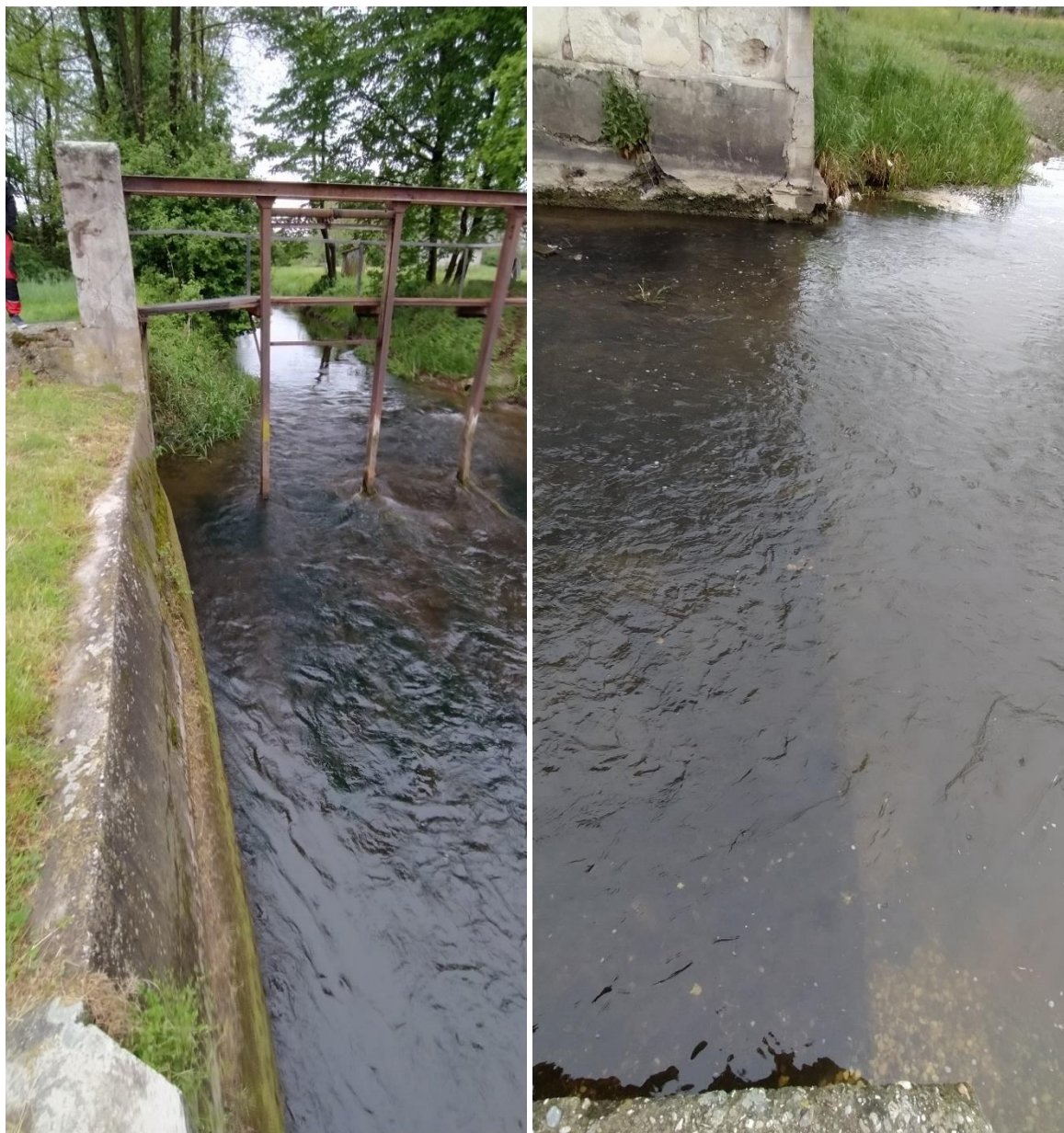
Slika 4.1-4 a) detalj ustave i obalnog zida uz ustavu; b) betonirano korito i prag uz staru mlinicu na mjestu gdje se postavlja turbina
