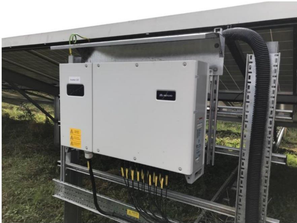
Slika 1.1-5 Primjer montaže izmjenjivača niza
