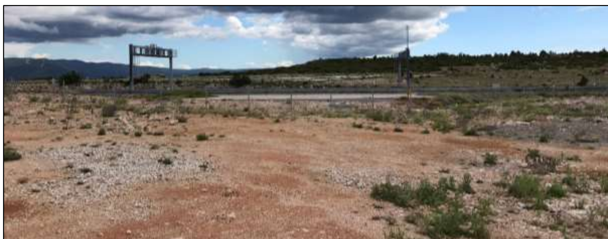
Slika 2.1.-10. LOKACIJA 6. južna granica deponije i pristupna točka s autoceste A1
