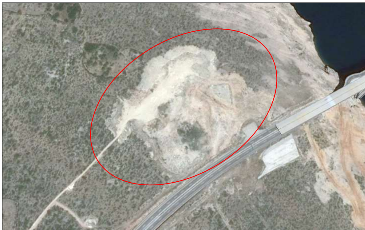
Slika 2.1.-2 Ortofoto prikaz lokacije deponije Maslenički most 2 s vidljivom pristupnom makadamskom cestom s jugozapadne strane (smjer Vinjerac)
