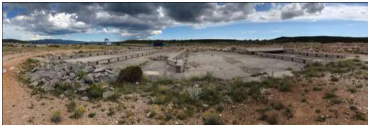
Slika 2.1.-9. LOKACIJA 5. ostaci temelja građevine na gornjem platou
