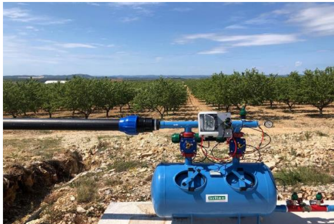
Slika 1.5 Pješčana filterska stanica, Izvor: Sustav navodnjavanja za plantažu maslina k.č. br. 3718/5 k.o.Biograd, glavni projekt – građevinsko-tehnološki, Ured ovlaštenog inženjera građevinarstva Željko Čirjak, Zadar
