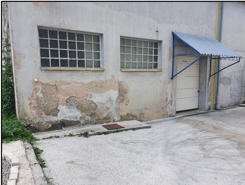
Slika 2.1-6. Šaht sabirne jame za sanitarne otpadne vode smještene ispod objekta bivše kotlovnice (fotografija snimljena 14.07.2021.)
