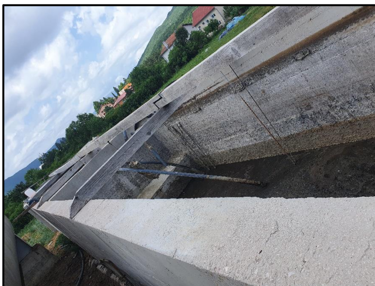
Slika 2.1-7. Uređaj za pročišćavanje tehnoloških otpadnih voda; fotografije snimljene 14.07.2021.
