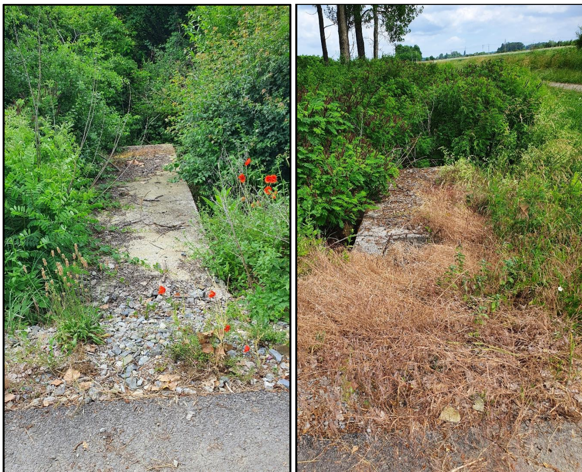
Slika 3.1.4-3. Fotografije (ukupno 2) ab propusta ispod nekategorizirane pristupne ceste do lokacije zahvata snimljene u lipnju 2021. (Fidon, 2021.)
