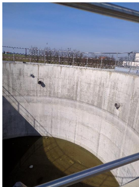
Slika 2-7 Sekundarni taložnik biološke obrade (lijevo) i neiskorišteni aeracijski bazen (desno)
