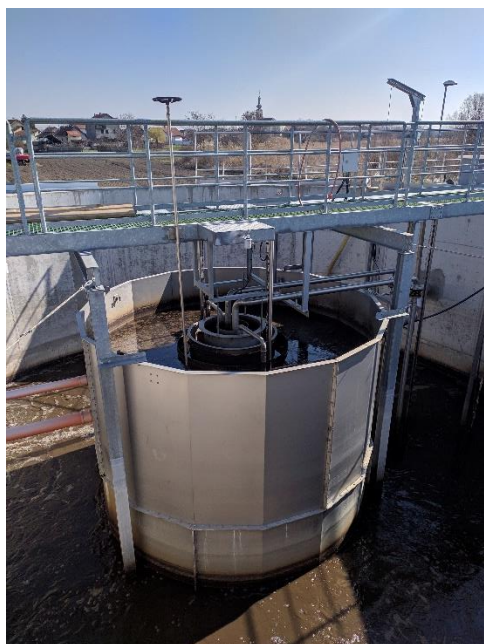
Slika 2-7 Sekundarni taložnik biološke obrade (lijevo) i neiskorišteni aeracijski bazen (desno)
