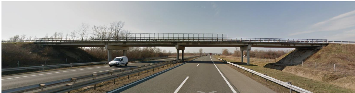
Fotografija A-1: Pogled na nadvožnjak 1 (Ivanić Grad) sa autoceste
