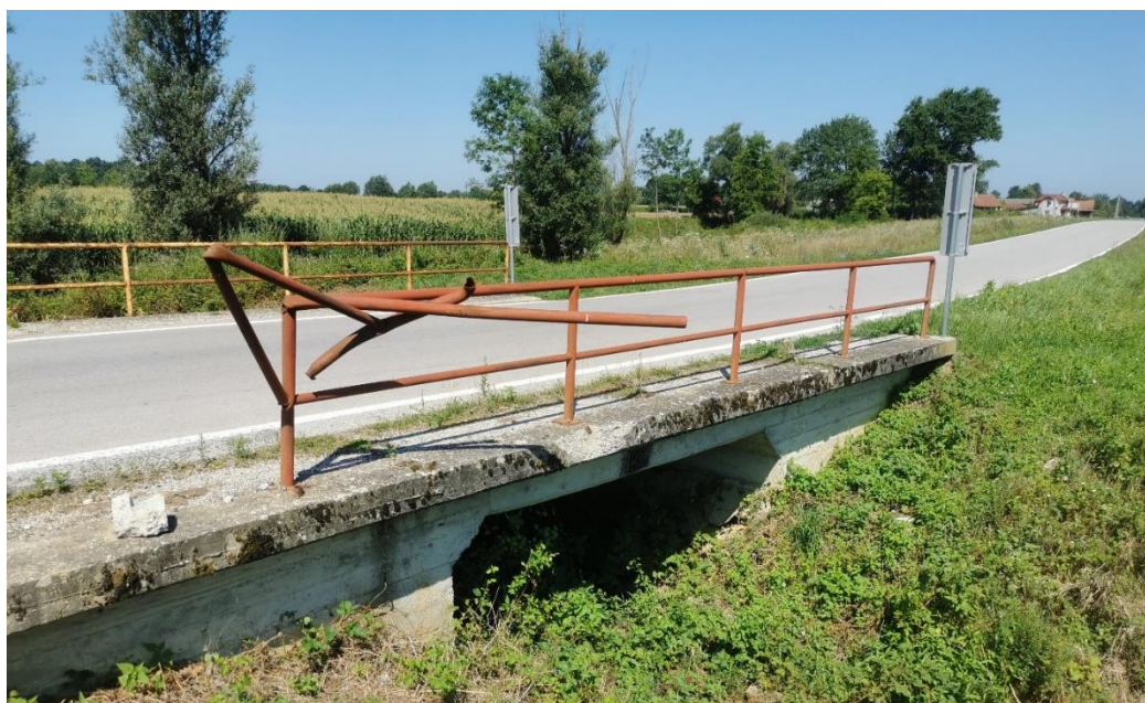
Fotografija A-2: Fotografija propusta 2
