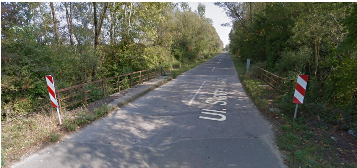
Fotografija A-8: Fotografija propusta 8 – pogled na propust
