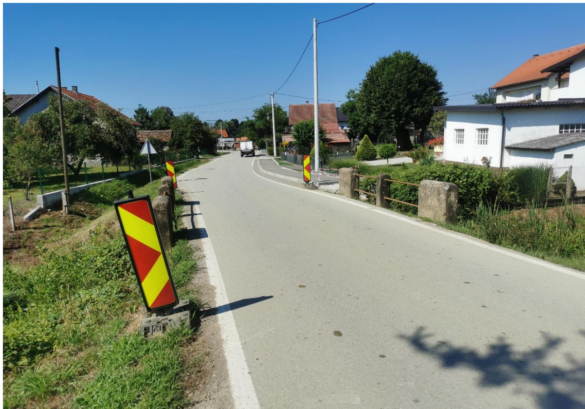
Fotografija A-6: Fotografija propusta 6 – pogled na propust
