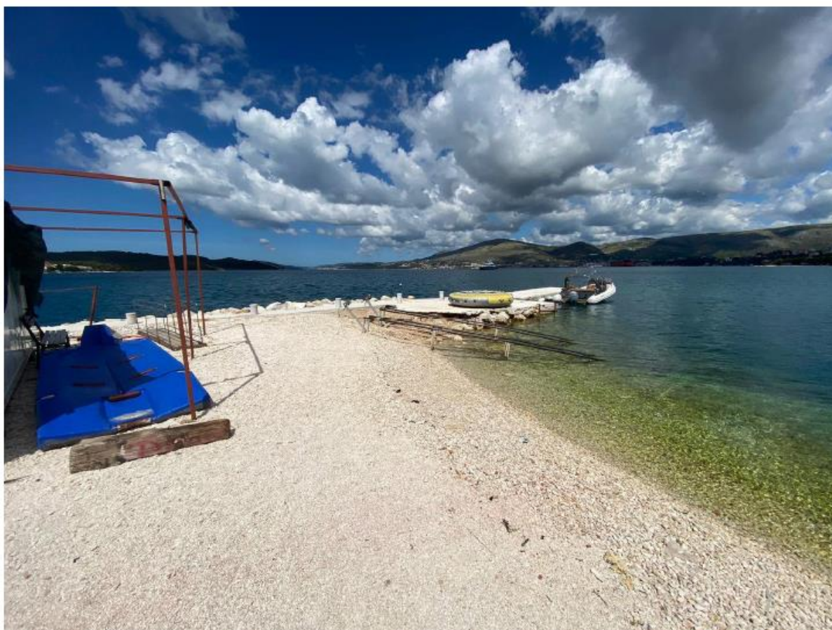
Slika 1.7 Pogled na sjeverni dio unutarnje strane glave postojećeg lukobrana sportske lučice
