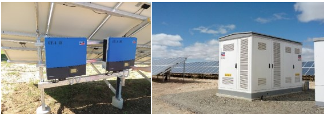
Slika 2.1-2 Koncepti smještaja izmjenjivača – izmjenjivači male snage (lijevo), izmjenjivači veće snage (desno)
