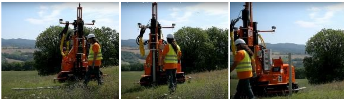
Slika 2.1-5 Priprema terena za postavljanje PV panela
