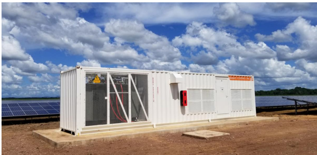
Slika 1./9. Primjer izmjenjivača, Gamesa Electric PV Station 5000; Izvor: www.gamesaelectric.com ; Izvor: Idejno rješenje SUNČANA ELEKTRANA OSTRVICA (25 MWp), Broj projekta: 01/03-2022; Izrađivač: EnergoVizija d.o.o., 20. lipanj 2022.
