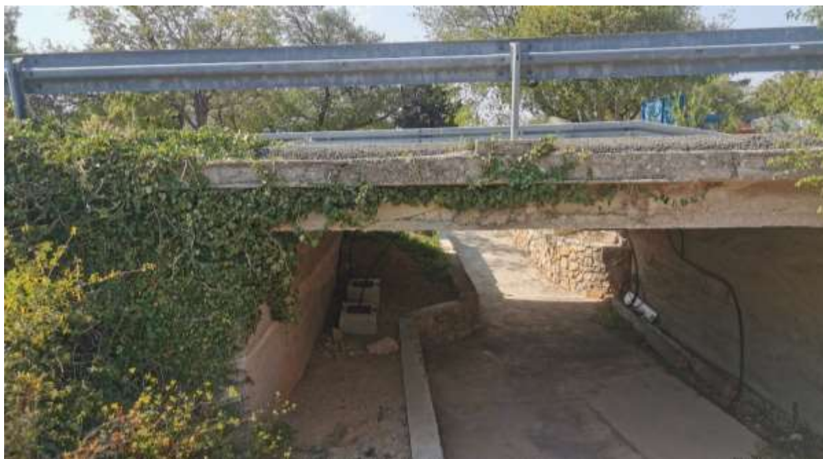
Fotografija A-1: Fotografija pothodnika
