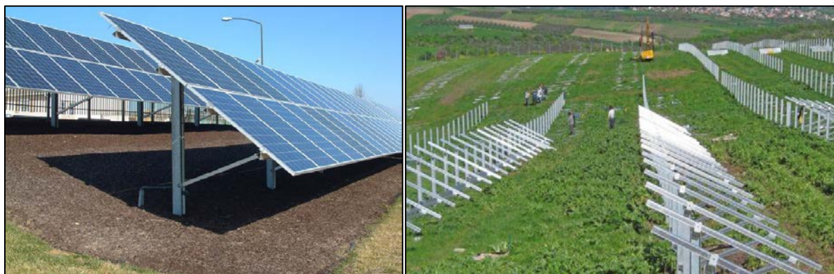
Slika 4. Detalj montaže podkonstrukcije bez temeljenja
