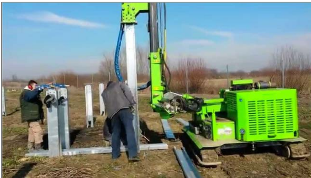
Slika 6. Prikaz stroja za zabijanje stupova u zemlju
