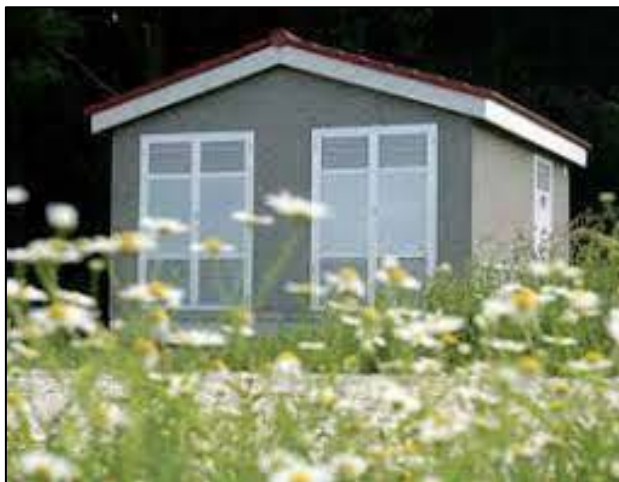
Slika 7. Transformatorska stanica tipa DTS 12(24)
