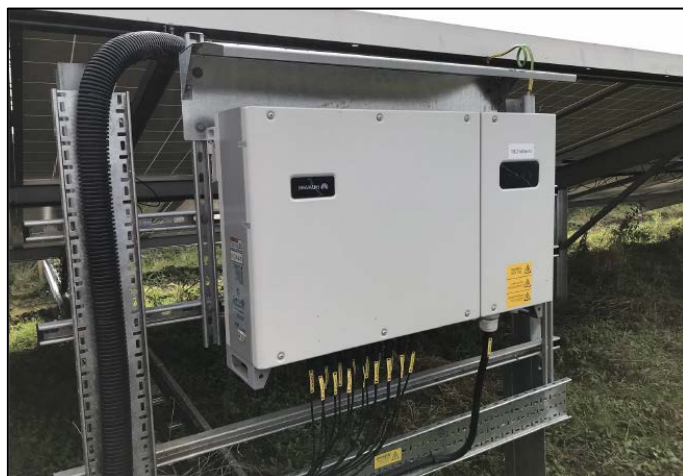
Slika 5. Detalj montaže izmjenjivača na podkonstrukciju
