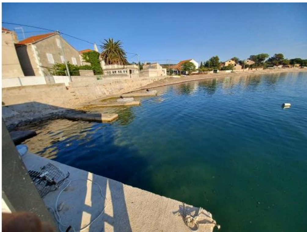
Slika 1.6 Lokacija novog obalnog zida
