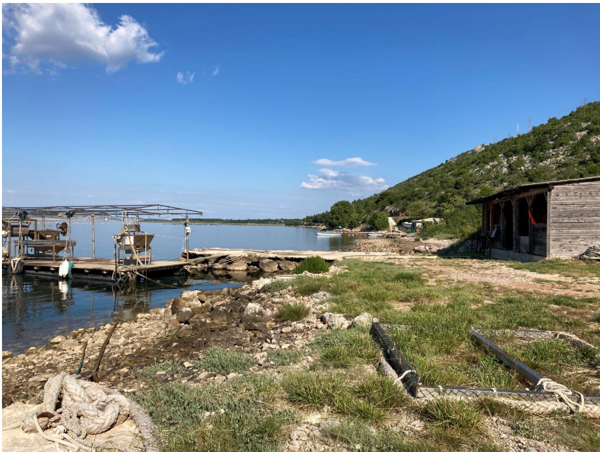
Slika 1.1-1 Postojeće stanje lokacije na kojoj je planirana gradnja, pogled sa istoka (Zeleni servis d.o.o., 01.06.2021.)
