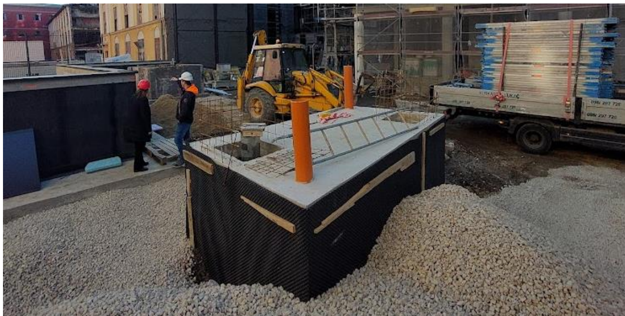
Slika 1.3. Izgrađeno betonsko okno zdenca.
