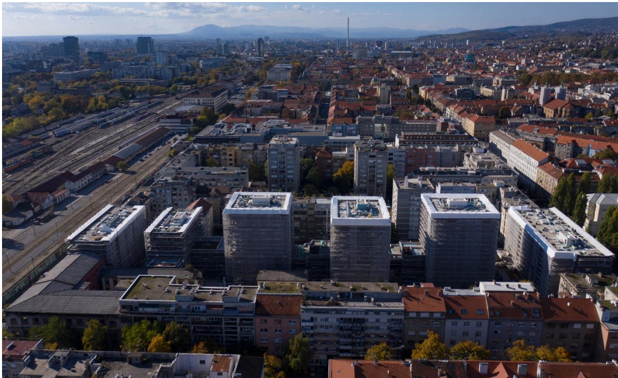
Slika 2.7. Pogled na stambeno-poslovne građevine na lokaciji Ulica kneza Branimira – Ulica kneza Borne u Zagrebu tj. „Park Kneževa“. Izvor: telegram.hr
