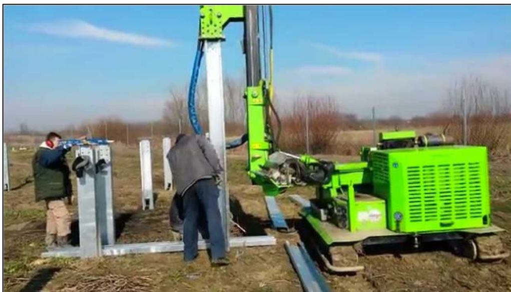
Slika 7. Prikaz stroja za zabijanje stupova u zemlju
