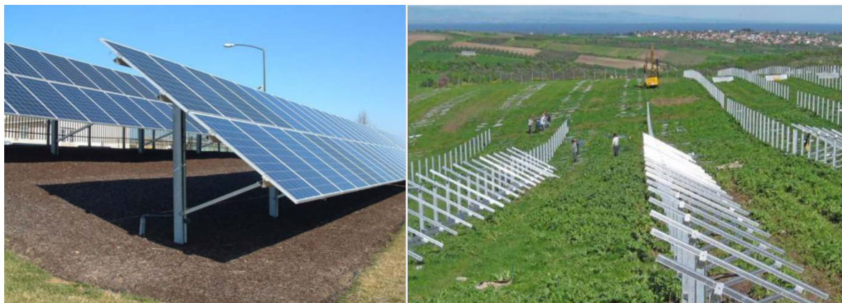
Slika 5. Detalji montaže podkonstrukcije bez temeljenja
