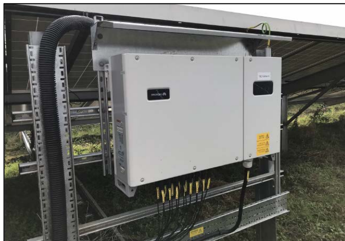
Slika 6. Detalj montaže izmjenjivača na podkonstrukciju
