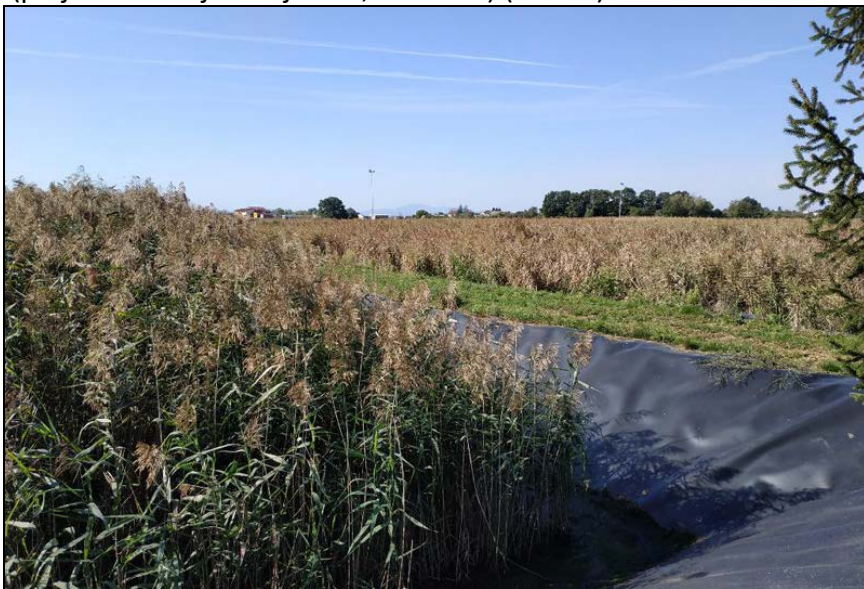
Slika 2. Polja za ozemljavanje mulja (Izvor: https://medjimurske-vode.hr/procistaci-otpadnih-voda )
