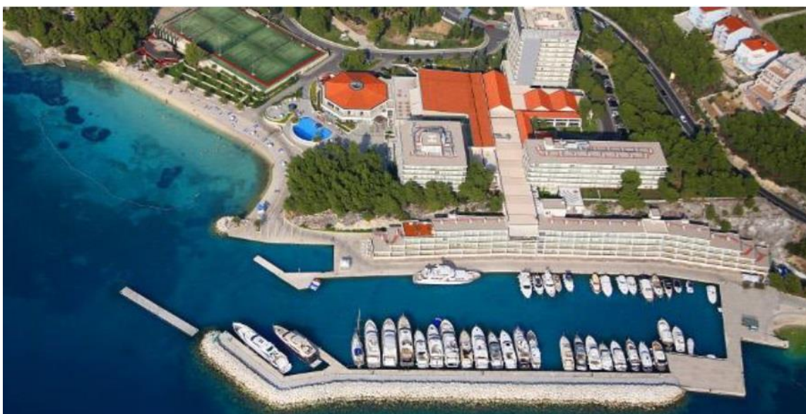
Slika 1.1-1 Postojeće stanje izgrađenosti marine „Lav“ (Izvor: Idejno rješenje )
