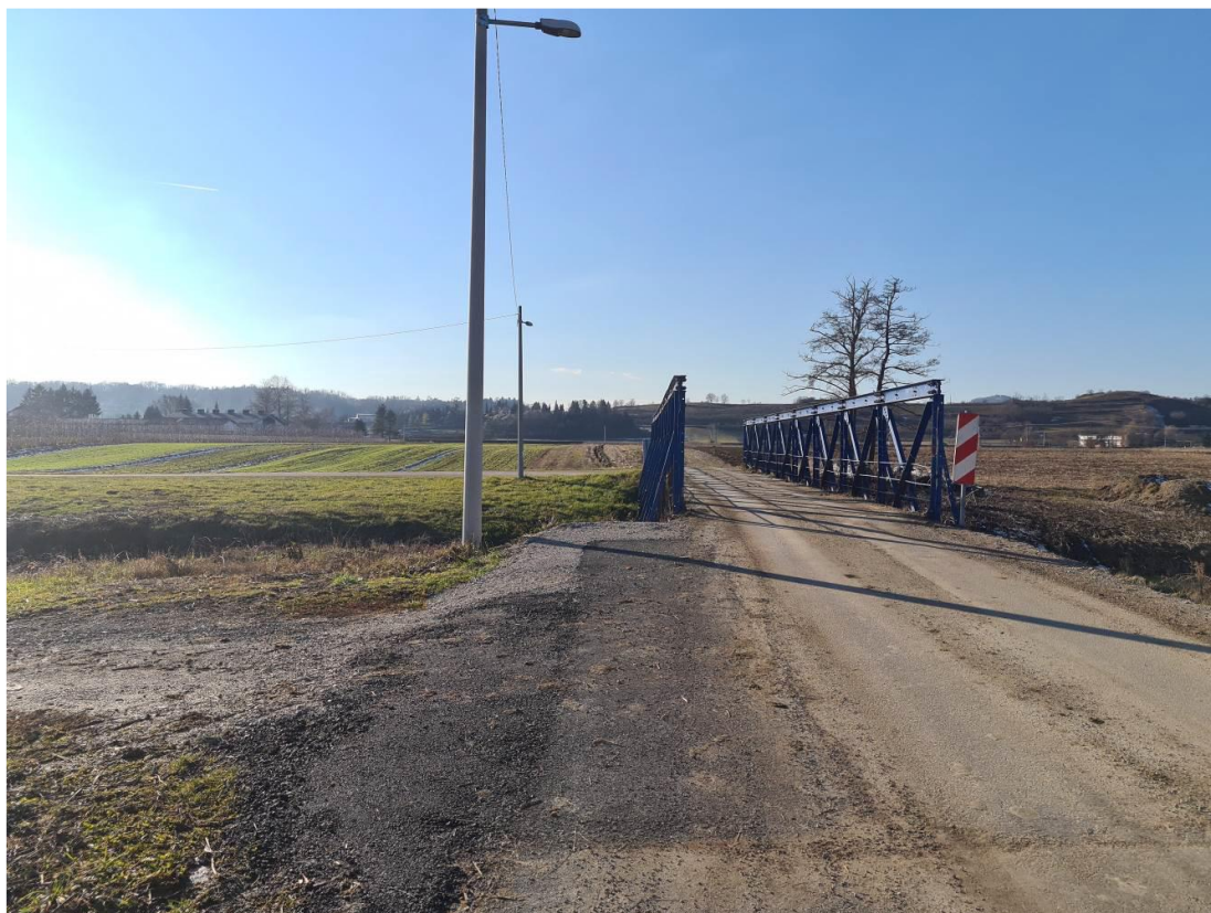
Slika 2.2 Pogled na lokaciju postojećeg mosta iz smjera Pribića prema Krašiću (lijevo -uređena površina za nogostup) (Izvor: Glavni građevinski projekt)
