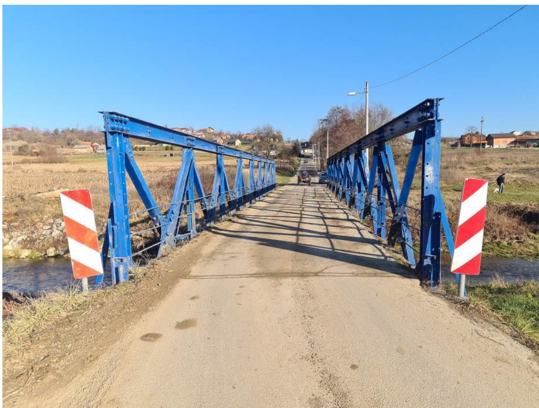
Slika 2.3 Pogled na lokaciju postojećeg mosta iz smjera Krašića prema Pribiću (Izvor: Glavni građevinski projekt)
