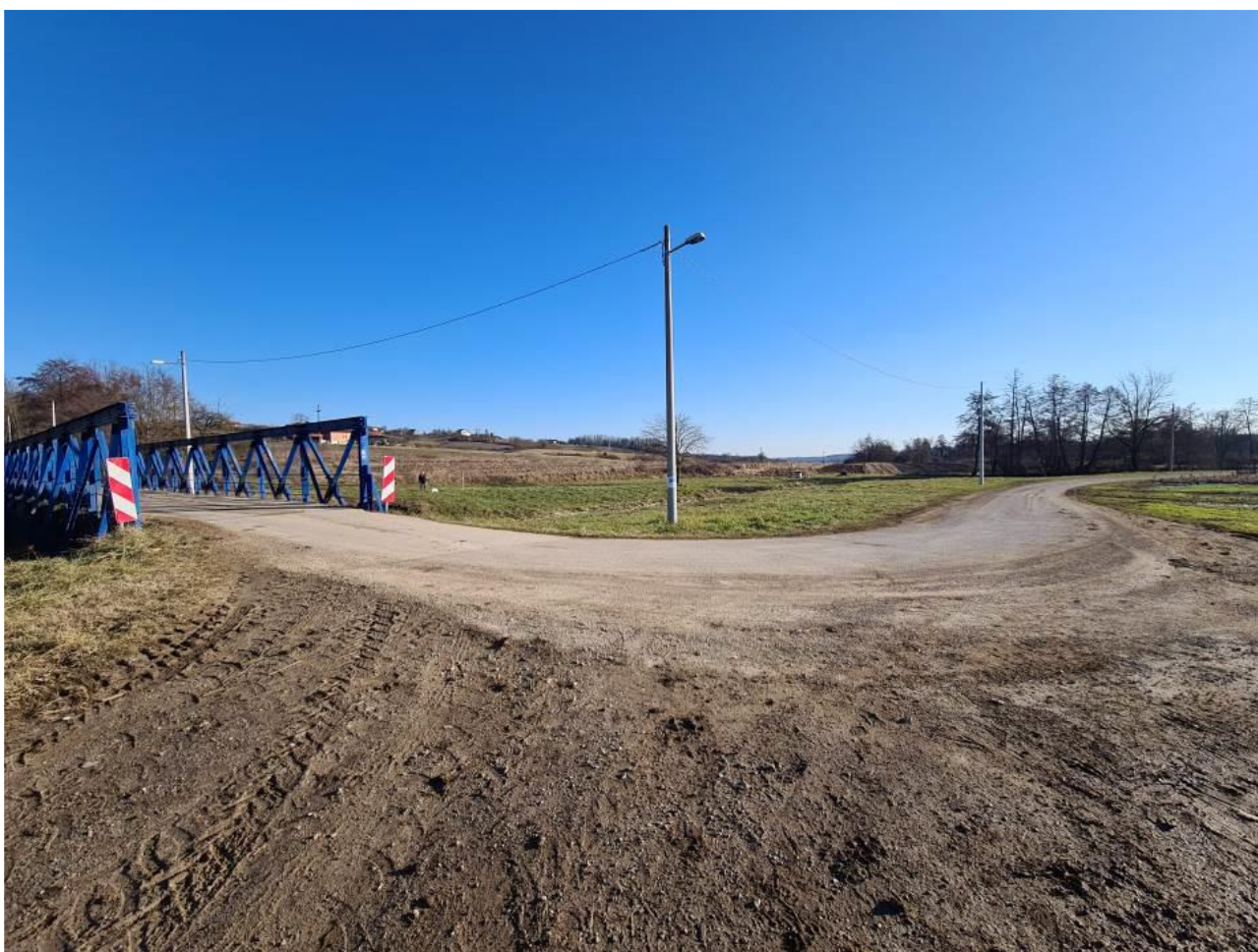
Slika 2.5 Pogled na oštar zavoj na prilazu mostu sa strane Krašića (Izvor: Glavni građevinski projekt)
