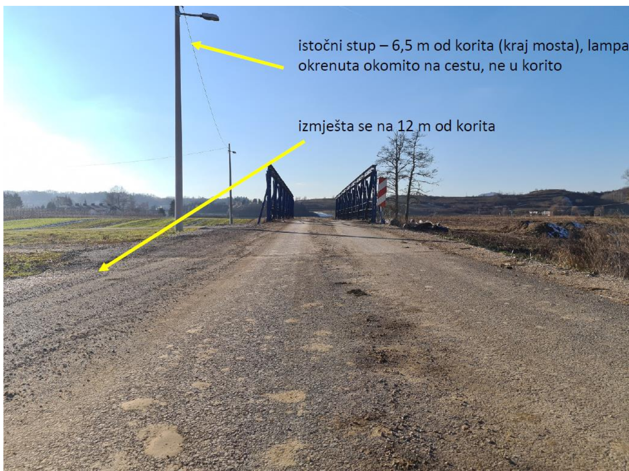
Slika 2.17 Prikaz izmještanja istočnog stupa rasvjetnog tijela (Izvor: Glavni građevinski projekt)
