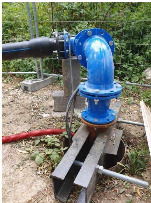
Slika 8. Naknadno montirane crpke na izvoru Sv.Anton tijekom interventnog uključenja u ljeto 2022.g. ; Lijevo – prebačena s izvora Rakonek kapaciteta 100 L/s, Desno – prebačena potopna crpka s izvora Mutvice kapaciteta 60 L/s.
