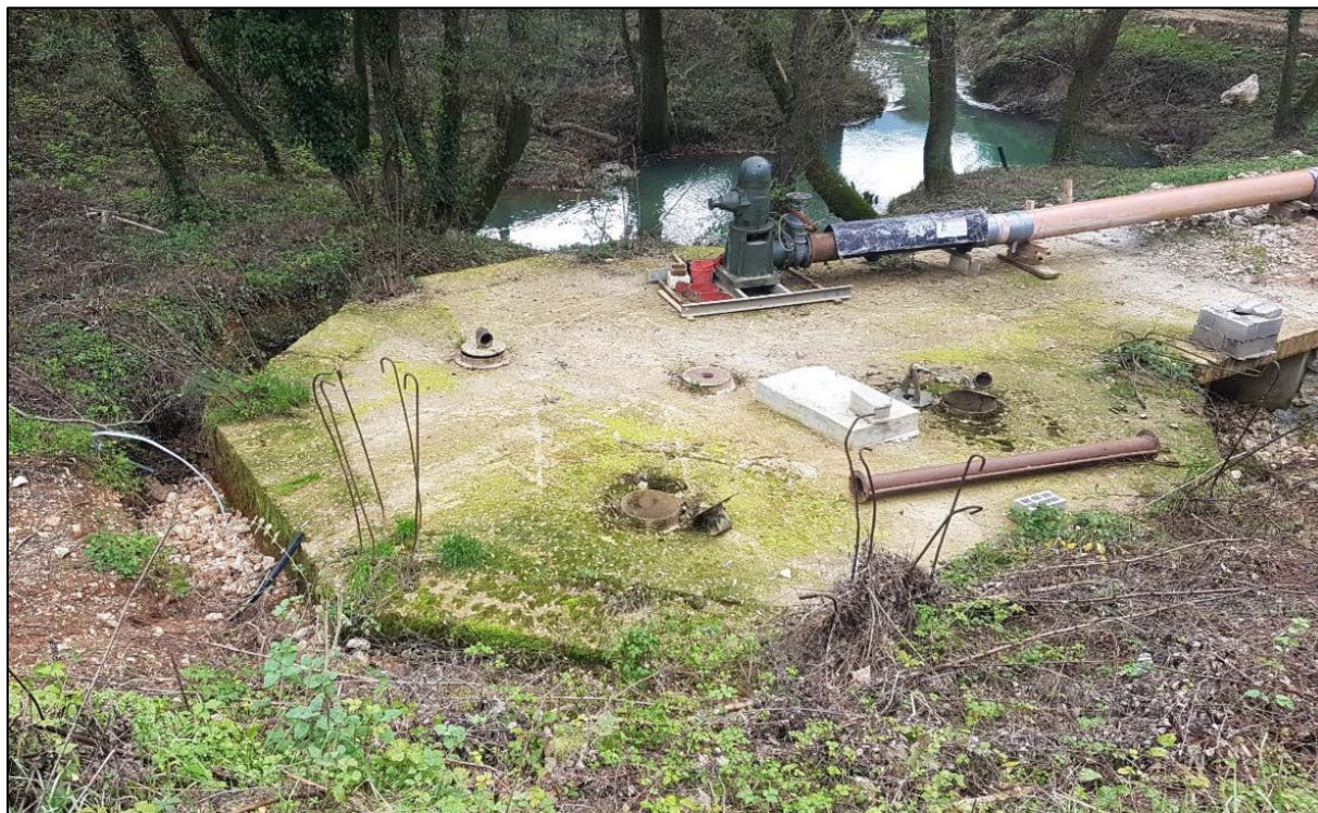
Slika 4. Postojeći AB temelj na lokaciji izvora Sv. Anton (pozicija izvedbe vodozahvatnog okna)
