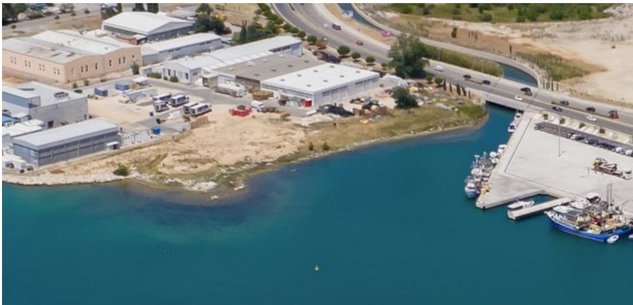
Slika 1.1 - 2 Pogled na lokaciju zahvata iz zraka (Izvor: https://www.port-authority-zadar.hr/virtual-gazenica/ ; pristup: lipanj, 2023. godine)
