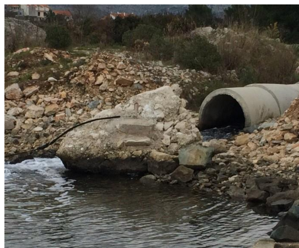
Slika 1./6. Ispust kanala Impol-TLM d.o.o.
