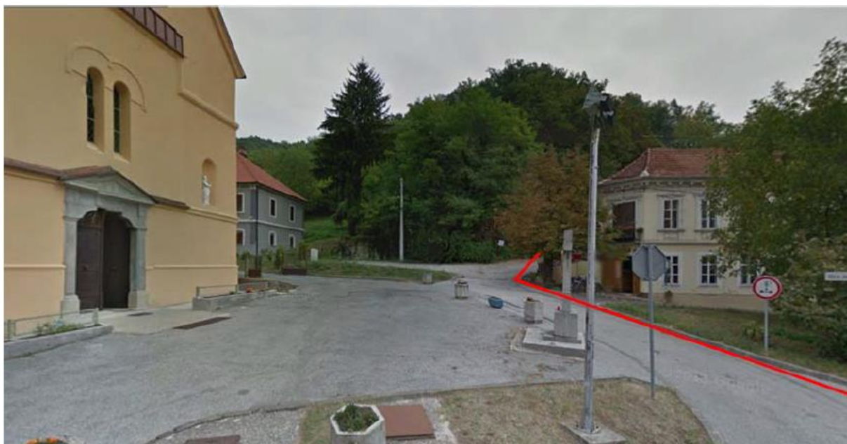
Slika 35. Prikaz predviđenog kanala KR-9.0 na području zone zaštite kulturnog dobra civilne građevine Termalno-lijebnički sklop
