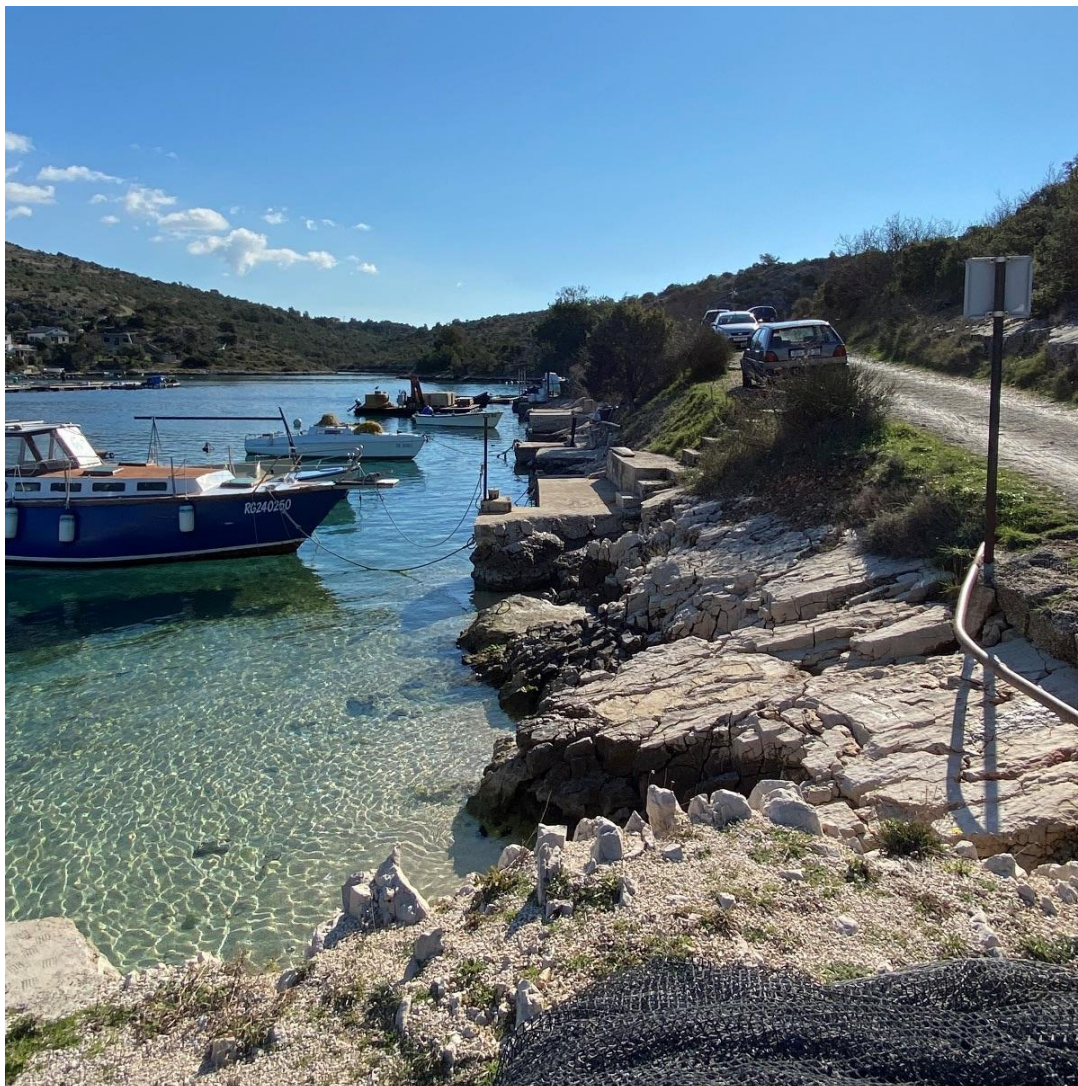
Slika 1.1-2 Postojeće stanje uvala Peleš - prikaz postojećeg gata, obale i ribogojilišta (Zeleni servis d.o.o., veljače 2021.)
