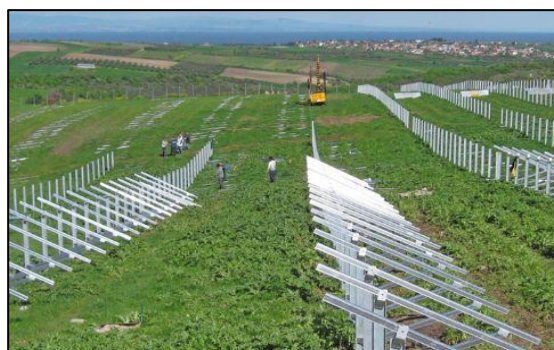
Slika 6. Prikaz FN modula na montažnoj konstrukciji na zemljanoj površini bez temeljenja (Izvor: Idejno rješenje za „Solarna elektrana Trenkovo“, IVICOM Consulting d.o.o., svibanj 2022)
