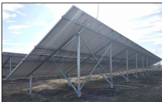
Slika 6. Prikaz FN modula na montažnoj konstrukciji na zemljanoj površini bez temeljenja (Izvor: Idejno rješenje za „Solarna elektrana Trenkovo“, IVICOM Consulting d.o.o., svibanj 2022)
